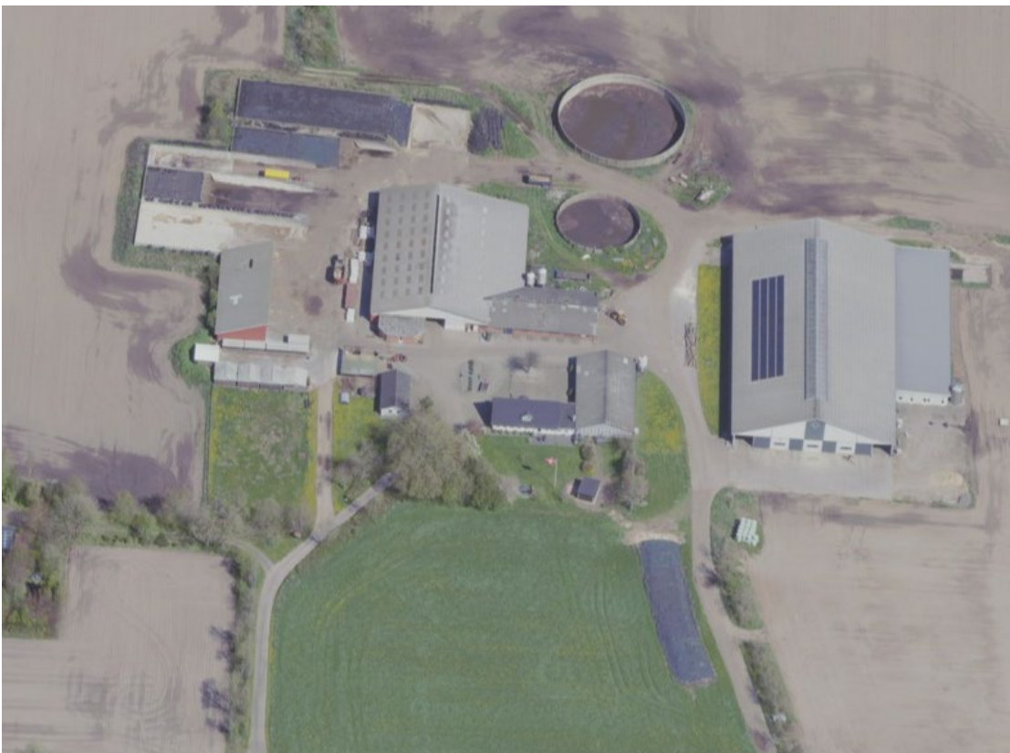
Figur. 2: Nuværende bygninger på Nørregårdsvej 4. Kilde: skraafoto.dataforsyningen.dk
