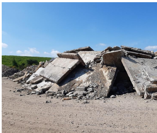
Oplag af betonaffald, der skal flyttes til befæstet areal
