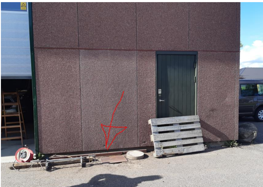
Placering af sandfangsbrønd til olieudskiller
