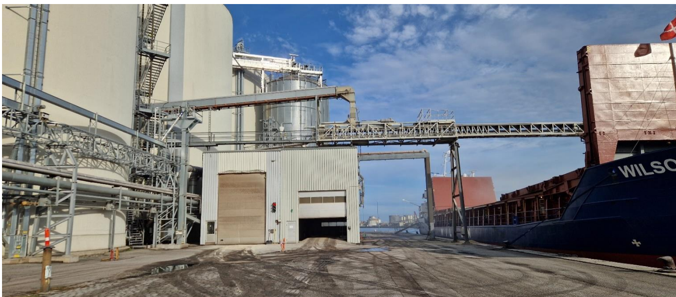
Ovenfor og nedenfor ses udlevering af afskallede hestebønner til skib. Dette sker via rør, hvor studs er monteret bælg og udsugning og foretages med så lille faldhøjde som muligt. Dette minimerer støvemissionen, men der vil dog fortsat være en smule diffus støvemission.
