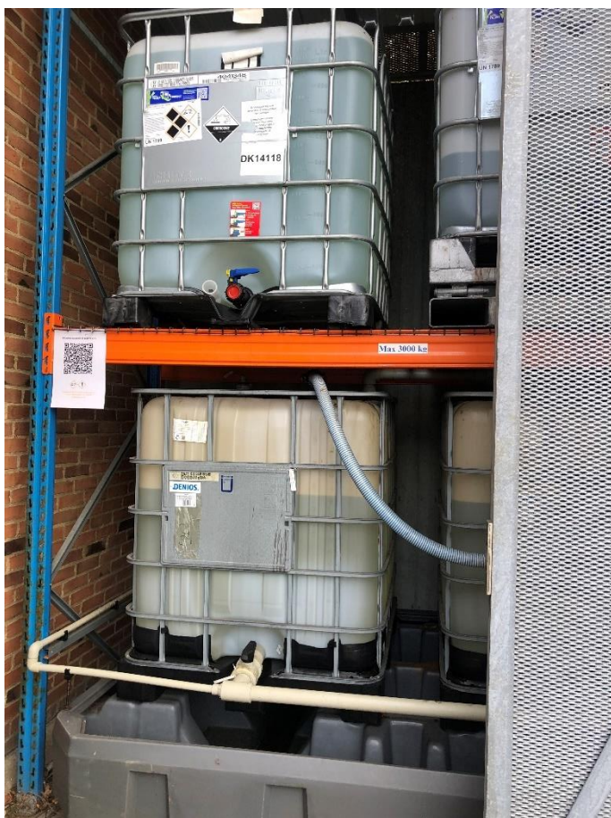
Billede 1. 4 stk. 1000 liters paller med saltsyre. Opbevares udenfor bygningen, i aflåst stålskur.
