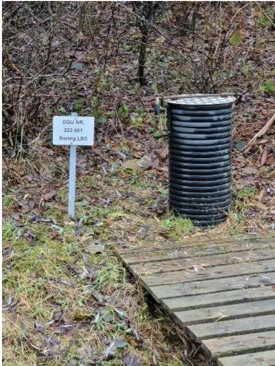
Moniteringsboring af grundvand opstrøms
