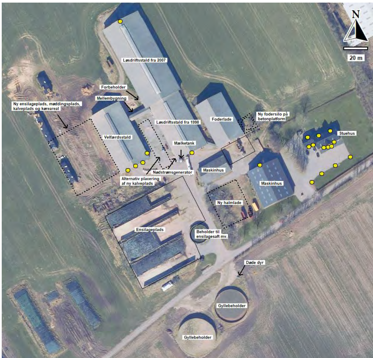
Figur 9: Støjkilder (og udvendig belysning)
