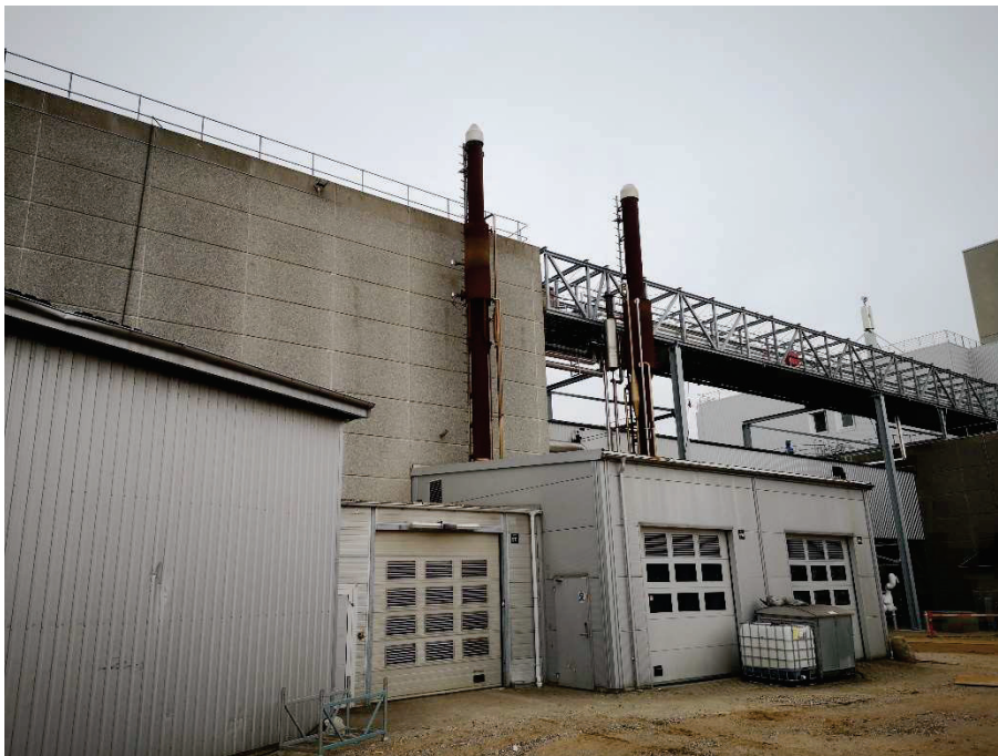
KC03 Indsugningsriste S. Samme Lw som for risten i nordgavlen, målt 29/1-24
