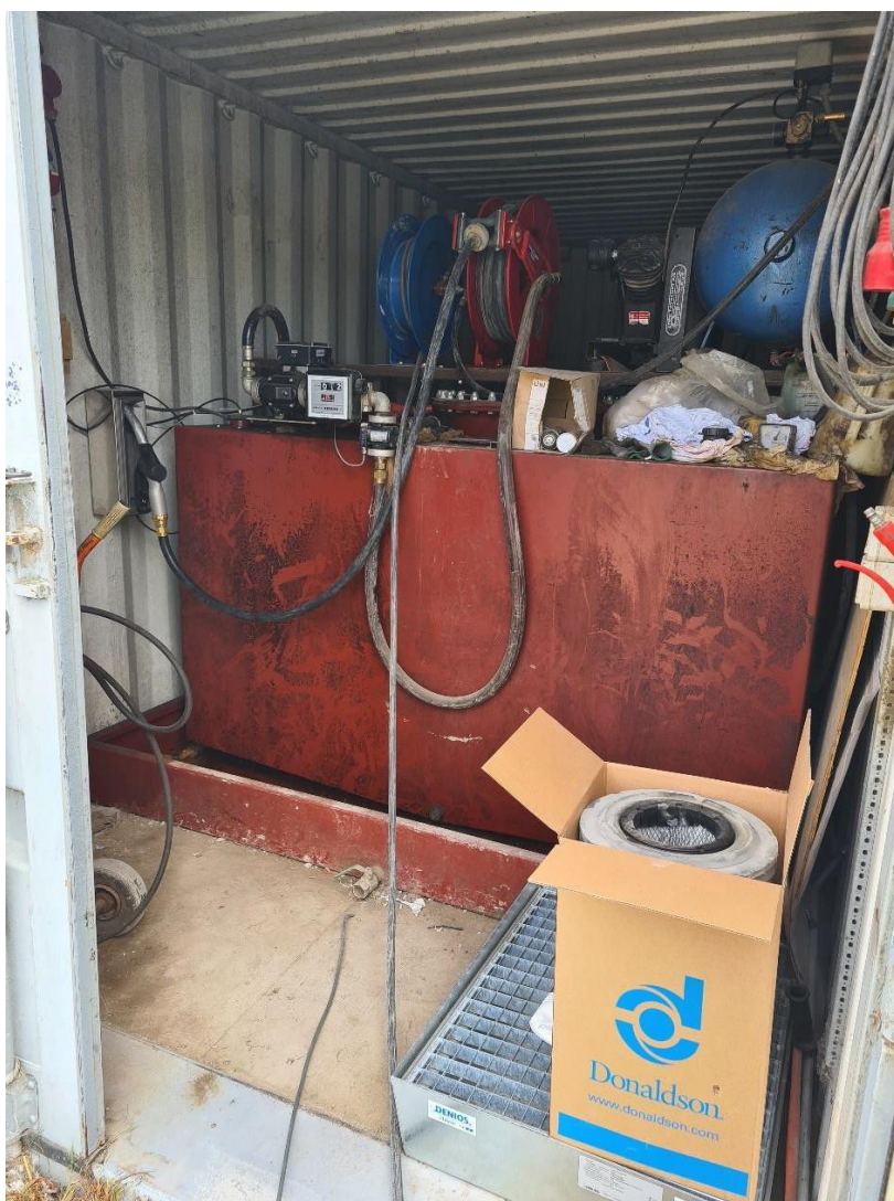
Billede 9 Container med dieselolietank og andre dunke på spildbakker.
