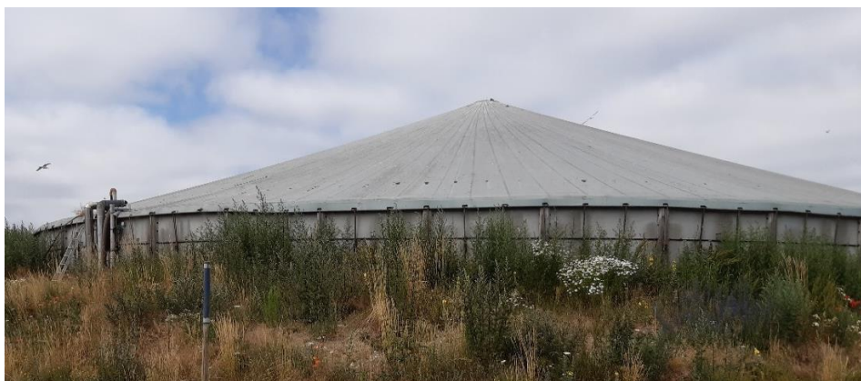
Billede 8 Overdækket perkolattank
