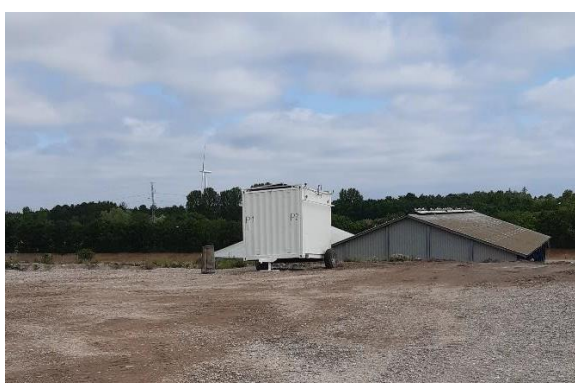
Billede 5 Isoleret vandtank ved celle 7b
