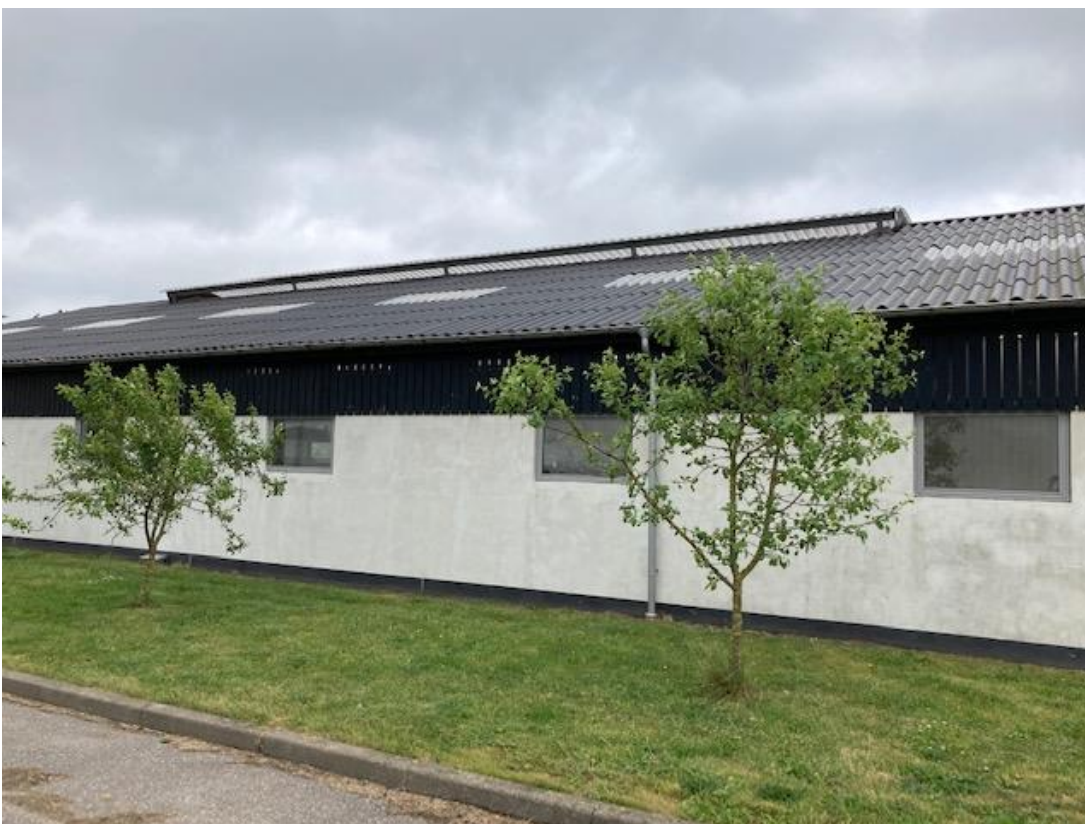
Figur 6. Opbygning af staldene, med faste mure, vinduer og vægindsugning under taget.
