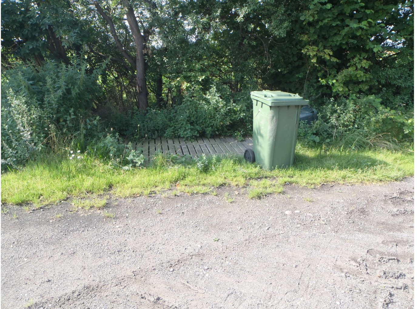
Billede af kadaverpladsen, udført med betonspalter, "kadaverkappe".
