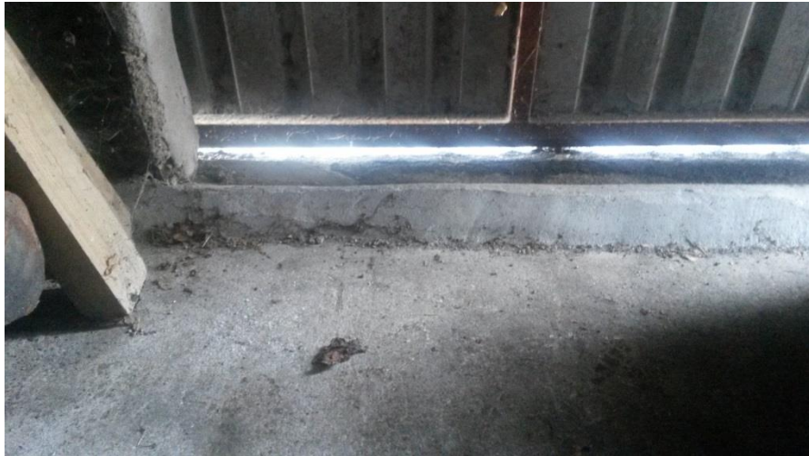
Opkant ved port i lager
