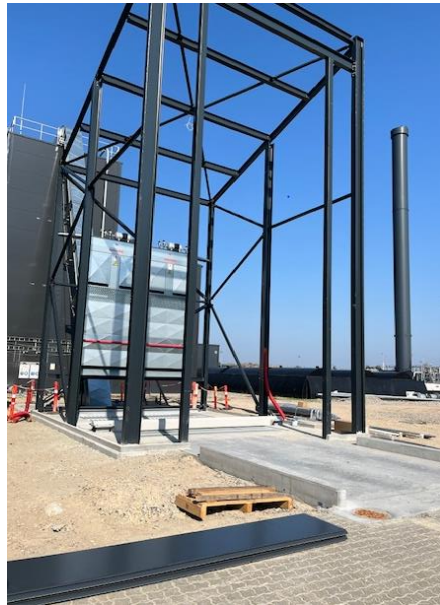
Foto 2: Påslag under opførsel.
