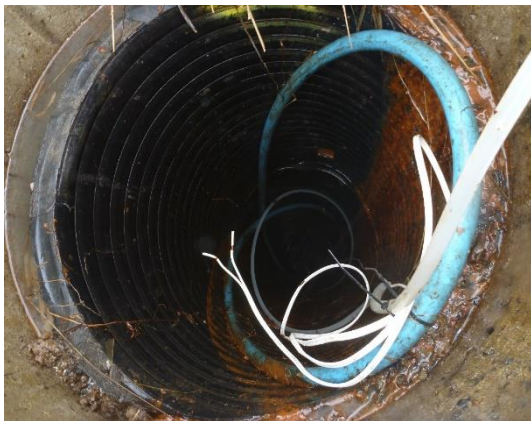
Foto 6: På deponiets nordlige del fik Miljøstyrelsen forevist en grundvandsboring.
