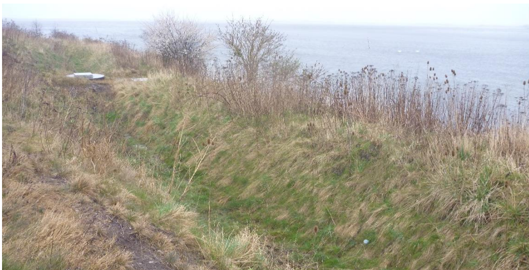
Foto 2: Ud mod Odense Kanal er etableret et dige.
