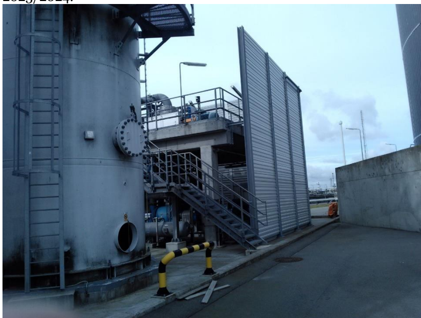
Foto 6: Ny støjskærm ved VRU2.
