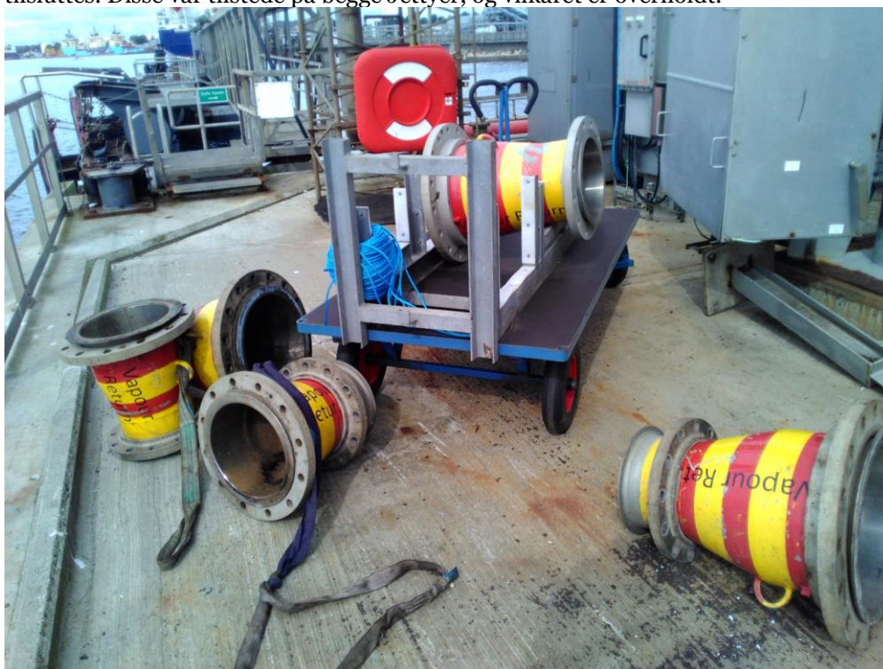
Foto 4: 5 stk. reduktionskoblinger på Jetty 2.
