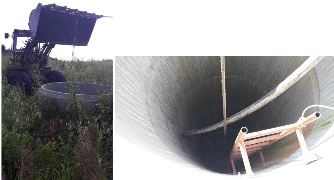
Foto 3 og 4. Ny pumpe er hejst ned i perkolatbrønden.
