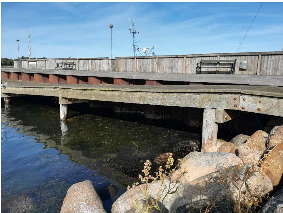
Deponiets sydside med spuns bag sænket niveau
