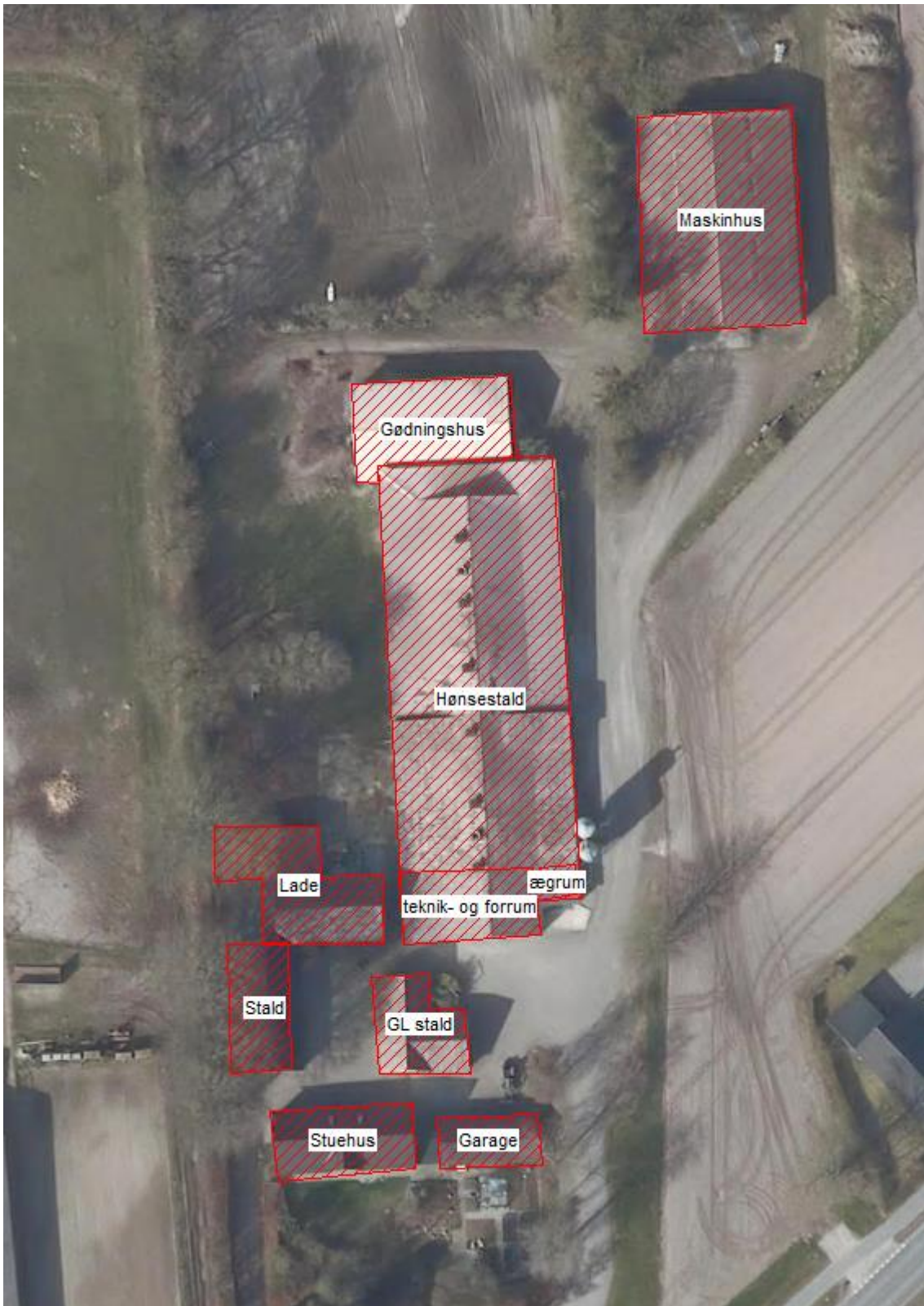
Figur 1: oversigt over ejendommen Steppingvej 34
