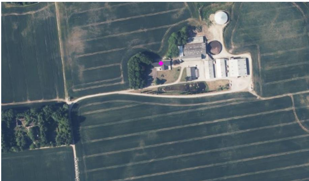
Figur 1: Oversigts foto, af ejendommen Korning Nørremark 35, og placering af nærmeste nabo (KortInfo)
