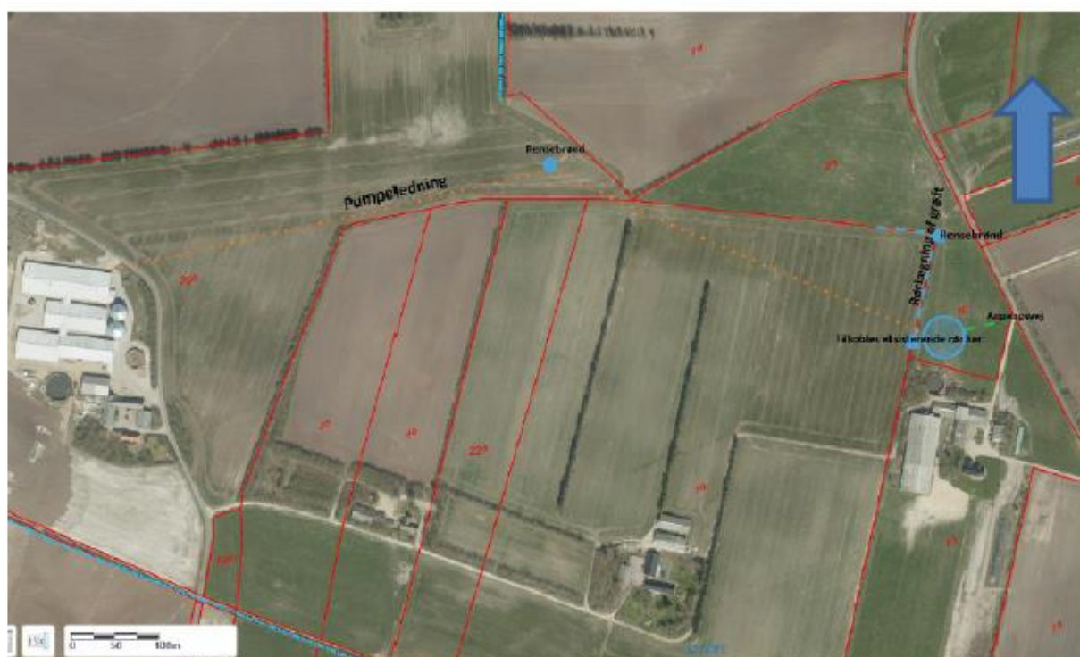
Figur 3. Gylletank på Brondbjergvej 10 med pumpeledning til Sdr. Stabyvej 8.
