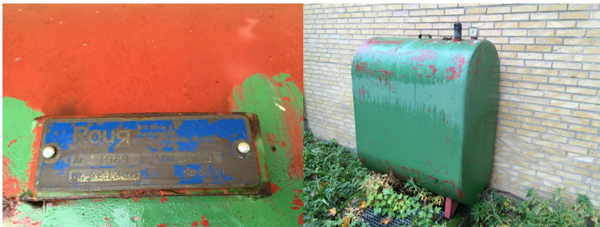
1200 liters fyringsolietank (billede fra tilsyn 2016).
