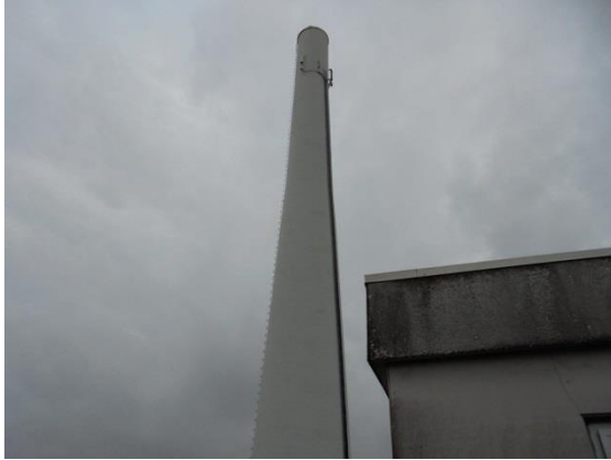
Skorsten med 2 røg-rør
