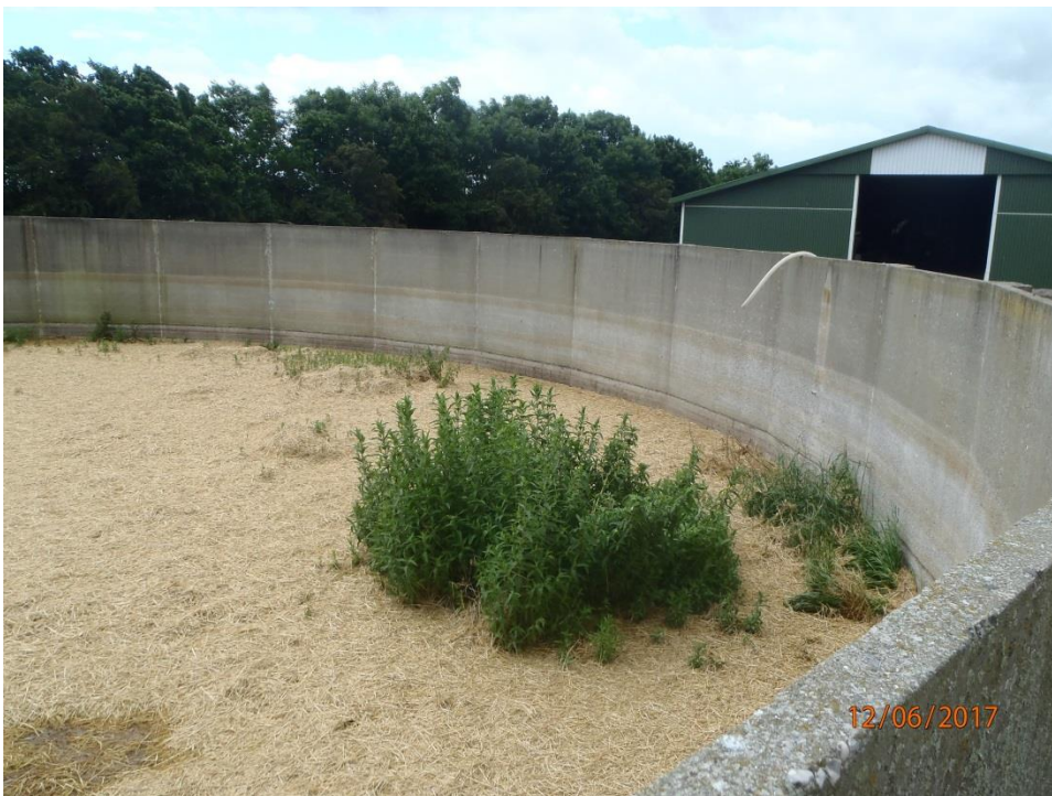
Billedet viser flydelaget på din gyllebeholder på 1000m 3 som er beliggende på Havlækkevej 69
