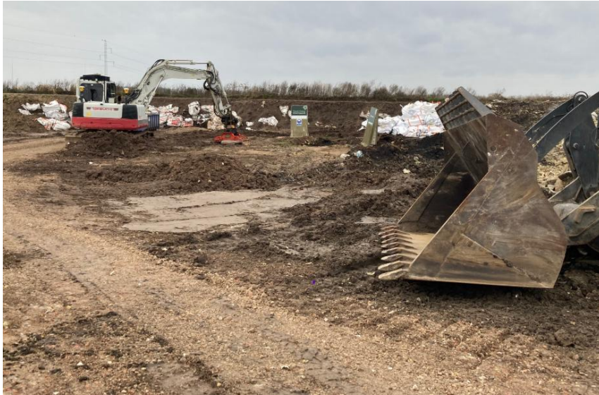
Foto 3. Asbestcelle og afsætningsplads.
