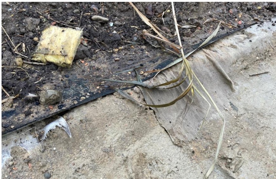
Foto 5. Kanten af den eksisterende membran på C1. Plastmembranen og fiberdug se på foto.
