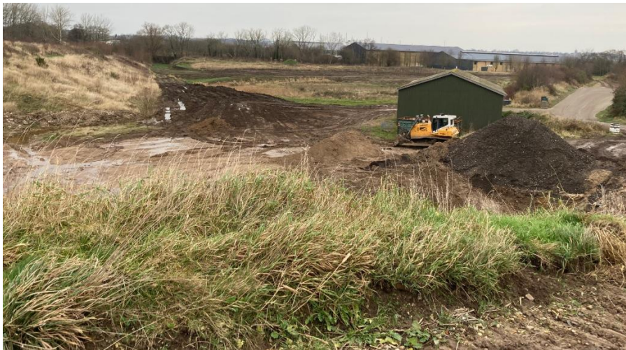
Foto 4. Område til planlagt ny deponeringsenhed. Foto taget fra deponeringsenhed C1 mod nordøst. Den grønne hal anvendes som maskinhus.
