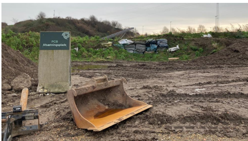
Foto 3. Afsætningsplads til PCB- affald.
