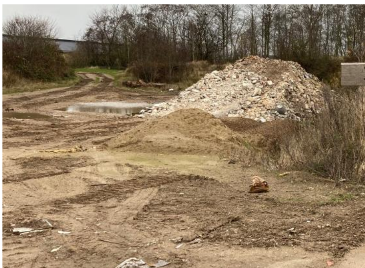
Foto 10. Område til neddeling og oplag af beton mv.
