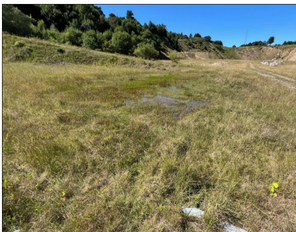
Foto 20. Vandhul ved nedkørsel til deponi og projekteret materialeplads.
