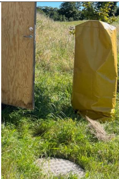
Foto 5. Brønddæksel og el-skab under gul presenning tilhørende afværgeboring/brønd AV2.
