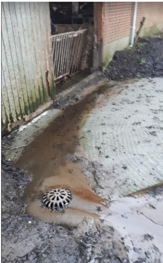
Figur 7. Brønd i forbindelse med befæstet areal, der er vist på figur 6.
