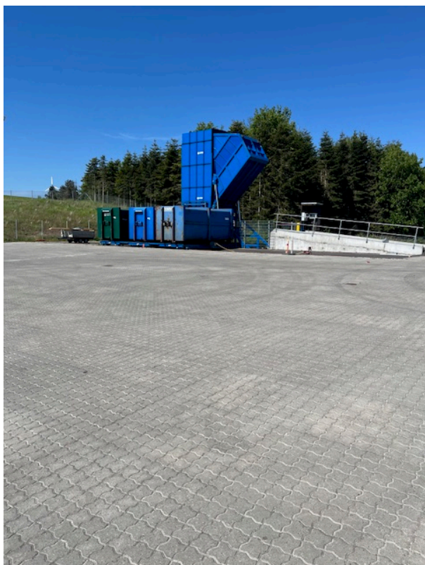
Komprimatoranlæg fra VARIG Teknik & Miljø, på Trolleborgvej.
