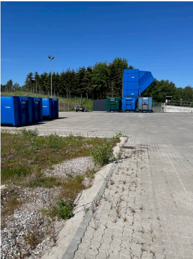
Komprimatoranlæg og ekstra containere til udskiftning. Set fra øst.
