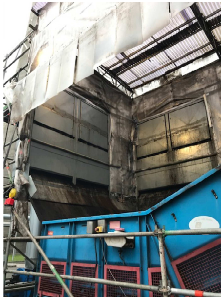
Midlertidigt påslag for træflis ved Blok 8
