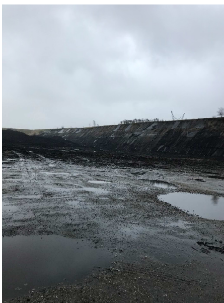
Kullager med sydlige støjvold hvor jordafdækningen er fjernet
