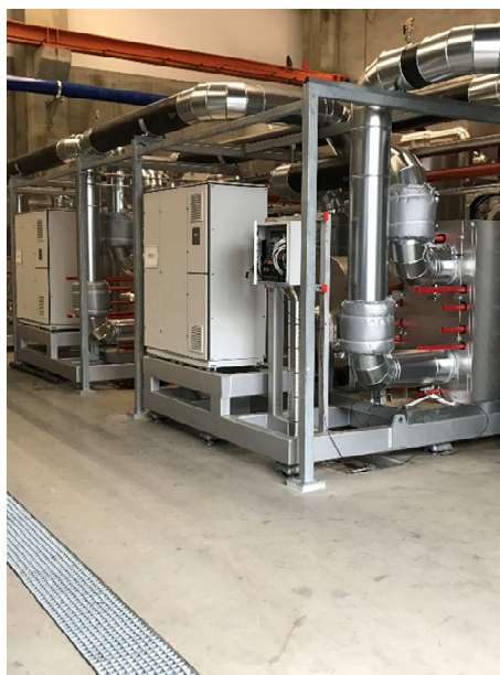
Varmepumper i Blok 3
