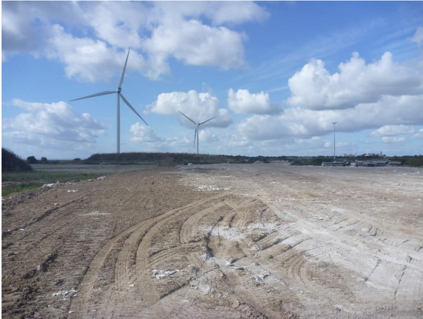
Enhed der er slutfærdig, men ikke godkendt nedlukket af miljømyndigheden.
