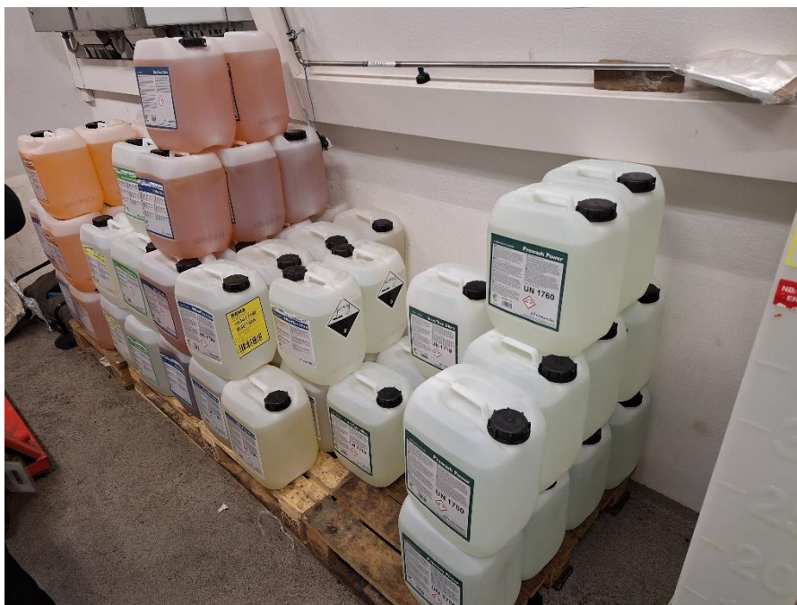
Flere paller fyldt med vaskemidler opbevaret uforsvarligt uden spildbakker i teknikerrum tilhørende vaskehal 2+3 Stationen er blevet gjort opmærksom på at de skal anskaffe sig spildebakker til disse ekstra vaskemidler i begge teknikerrum.
