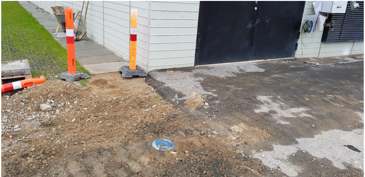
Boring BT1 ved nordøstlige hjørne af bygning for ovnlinje 5.
