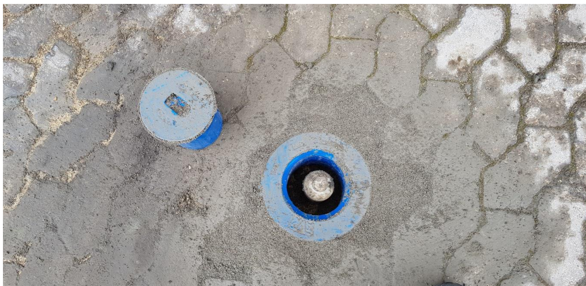
Boring BT4 efter afmontering af dæksel og filterrørets prop.
