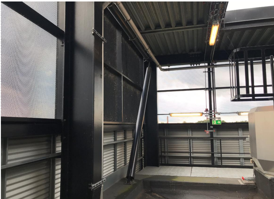
Figur 13: Facade mod S og Ø ved komponentkølere.
