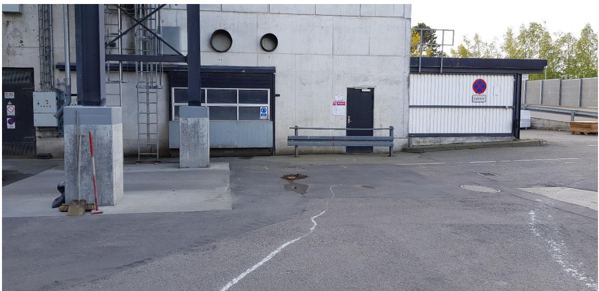
Boring BT8 ved restproduksilo for ovnlinje 4, før genopfyldning og lukning.
