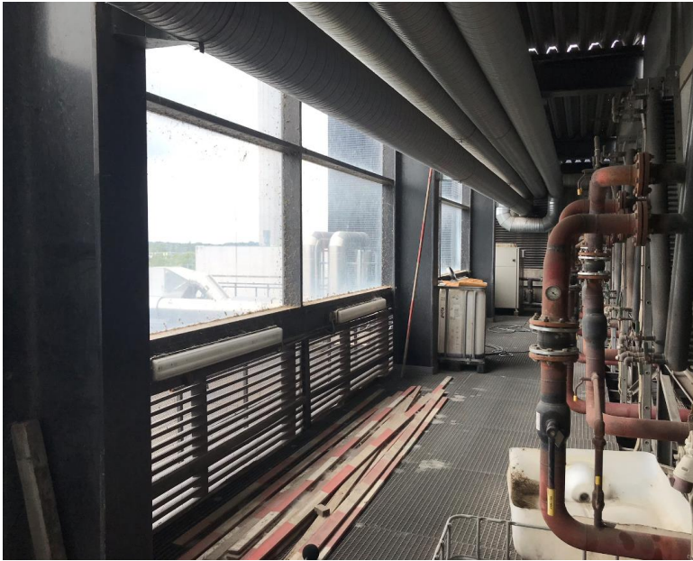
Figur 12: Facade mod V ved fjernvarmekølere.
