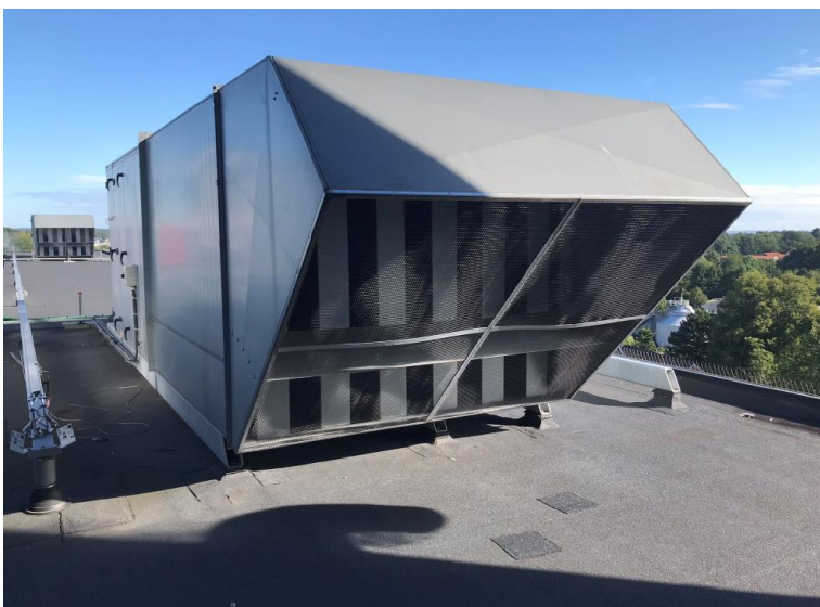
Figur 9: L5 luftindtag på tag.
