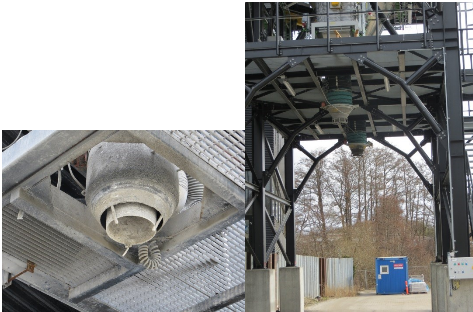
1. Udtag af tørt restprodukt ovn 4 (blandet fraktion). 2. Adskilte udtag ovn 5.
