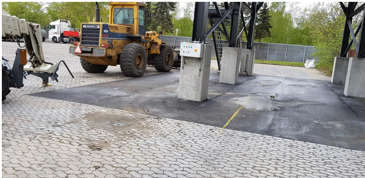
Boring BT4 ved restproduksilo for ovnlinje 5.
