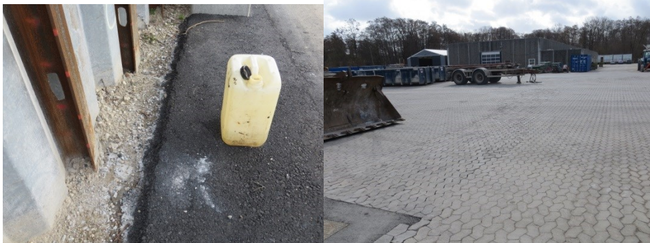
5,6,7 Belægninger under og rundt om udtaget af røggasrens ovn 5. 8. nærmeste afløb til kloakken foran udtag på areal med SF-stensbelægning
