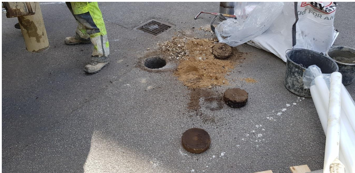
Boring BT3 ved afløbsbrønd i turbinegård, forgæves forsøg på at komme igennem. Før genopfyldning og lukning.
