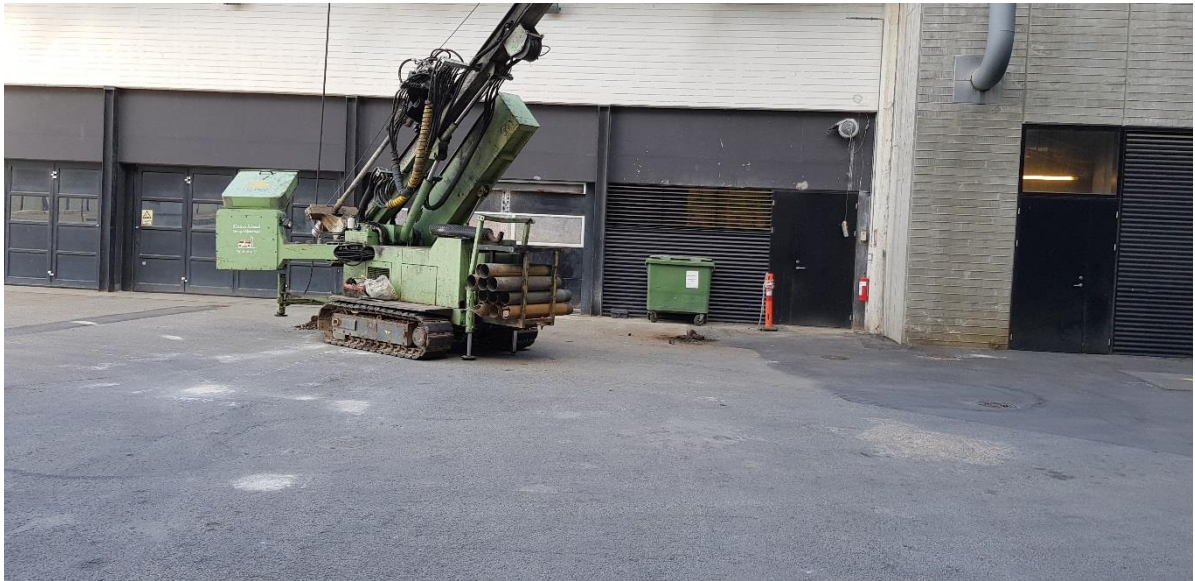
Boring BT5 og BT6 foran vandrensebygning, før genopfyldning og lukning.
