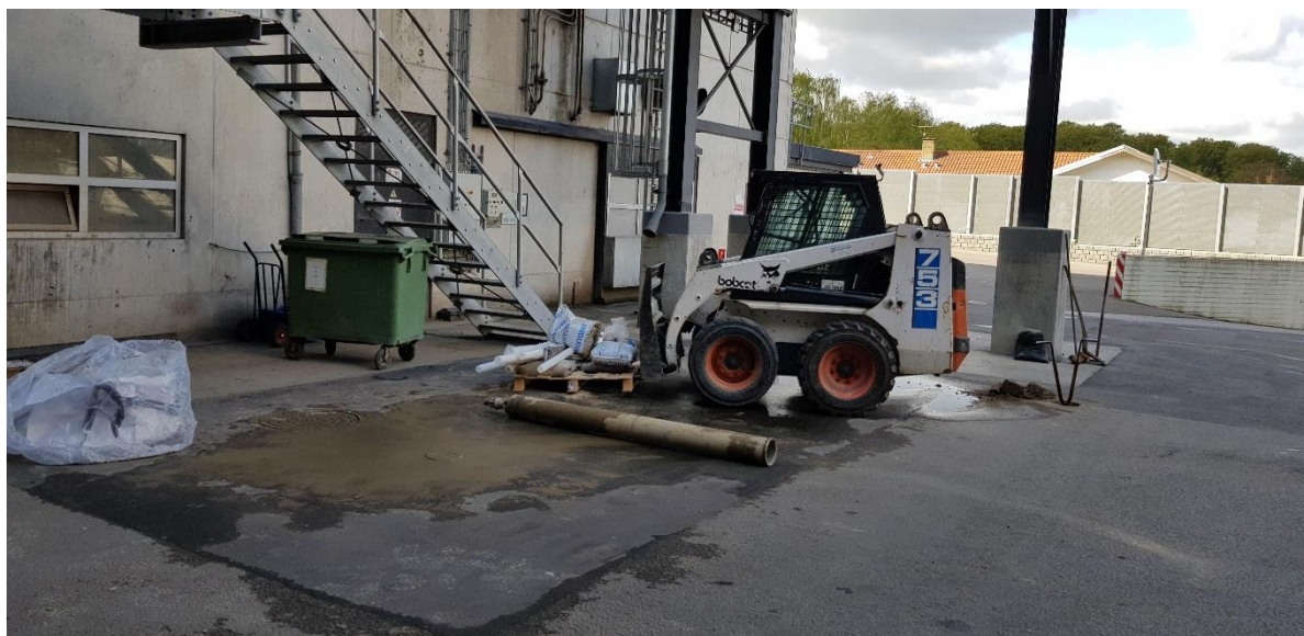
Boring BT2 ved olieudskiller i turbinegård.
