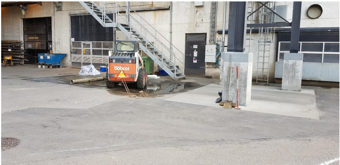
Boring BT7 ved restproduksilo for ovnlinje 4, før genopfyldning og lukning.
