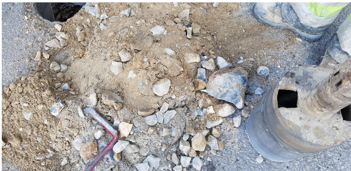
Boring BT3 ved afløbsbrønd i turbinegård. Boring i meget stenede fylldag.
