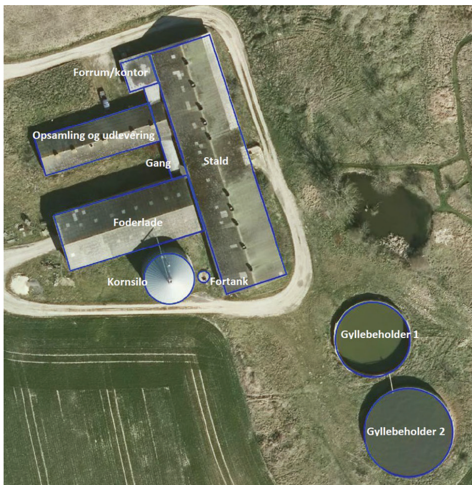
Figur 6 Anlægget på Tjørnebygård
