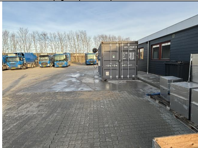
Container til dieseltank og tankplads
