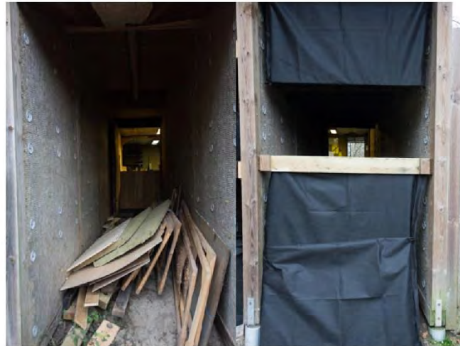
Figur 3 Til venstre ses standard lydsluse og til højre forsøg med indbygning af lyd- bafle.
