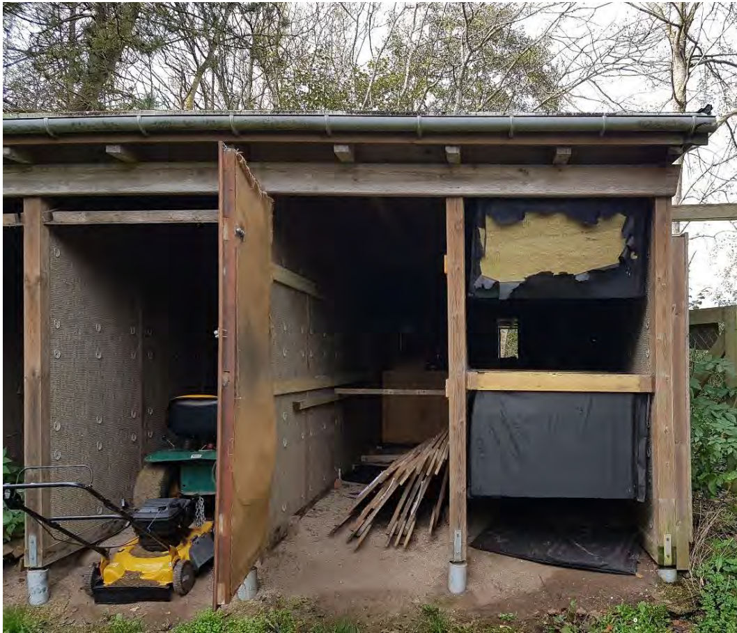
Figur 3. Skydehus med frembygninger på 100 m banen. I frembygningen til venstre er der ophængt lydtafler i kanalen for at reducere støjen.
