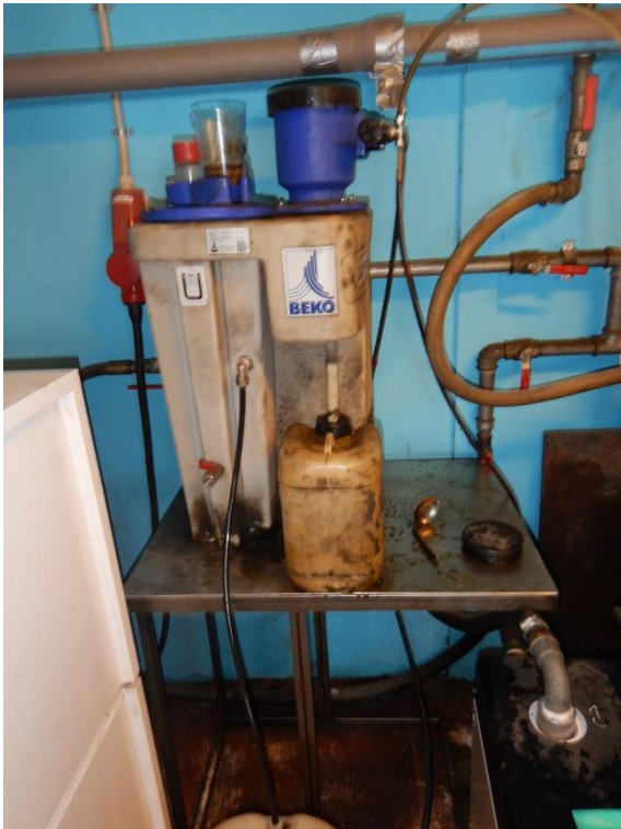
1. Kompressor med afledning af spildolie.
