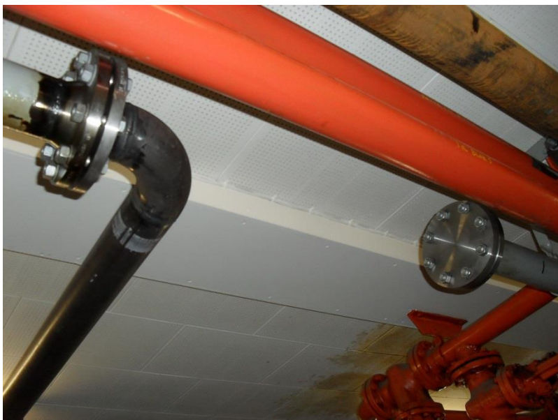
Foto 6. Omlagt rørføring, der sikrer at de to olietyper ikke kan sammenblandes.
