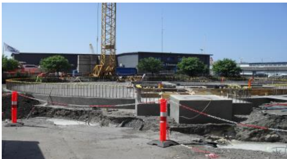
Foto 3. Opførelse af ny flissilo
