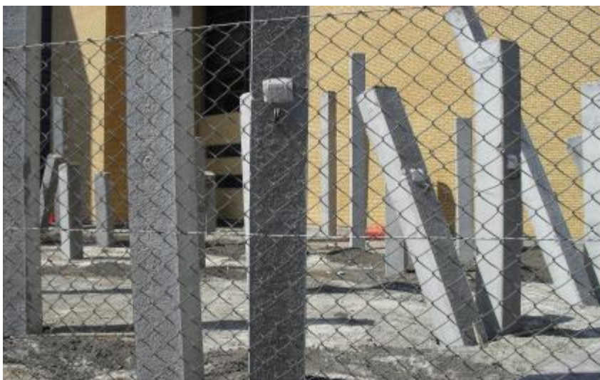
Foto 4. Pilotering til bygning med røggaskondensering
