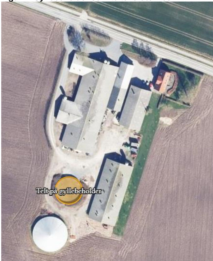
Figur 1. Gyllebeholder som teltoverdækkes
