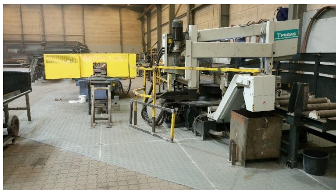
Billede nr. 28: Belægning under save. (2021)
