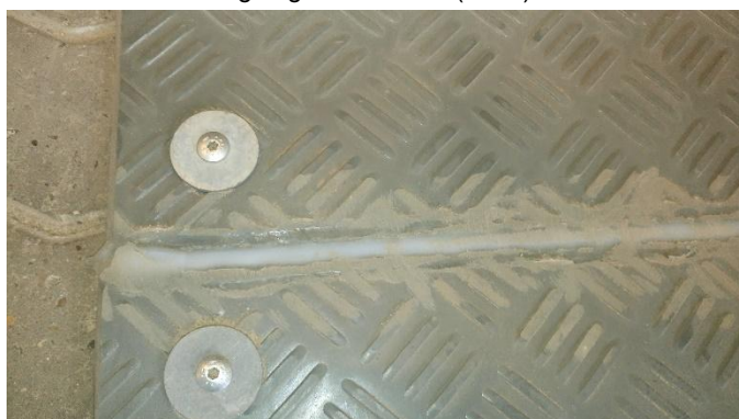
Billede nr. 30: Svejsning mellem 2 plastunderlag.
