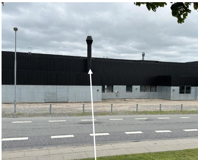
Billede nr. 9: Bygning og afkast til udsugningsanlægget fra plasmaskæreren (2026)
