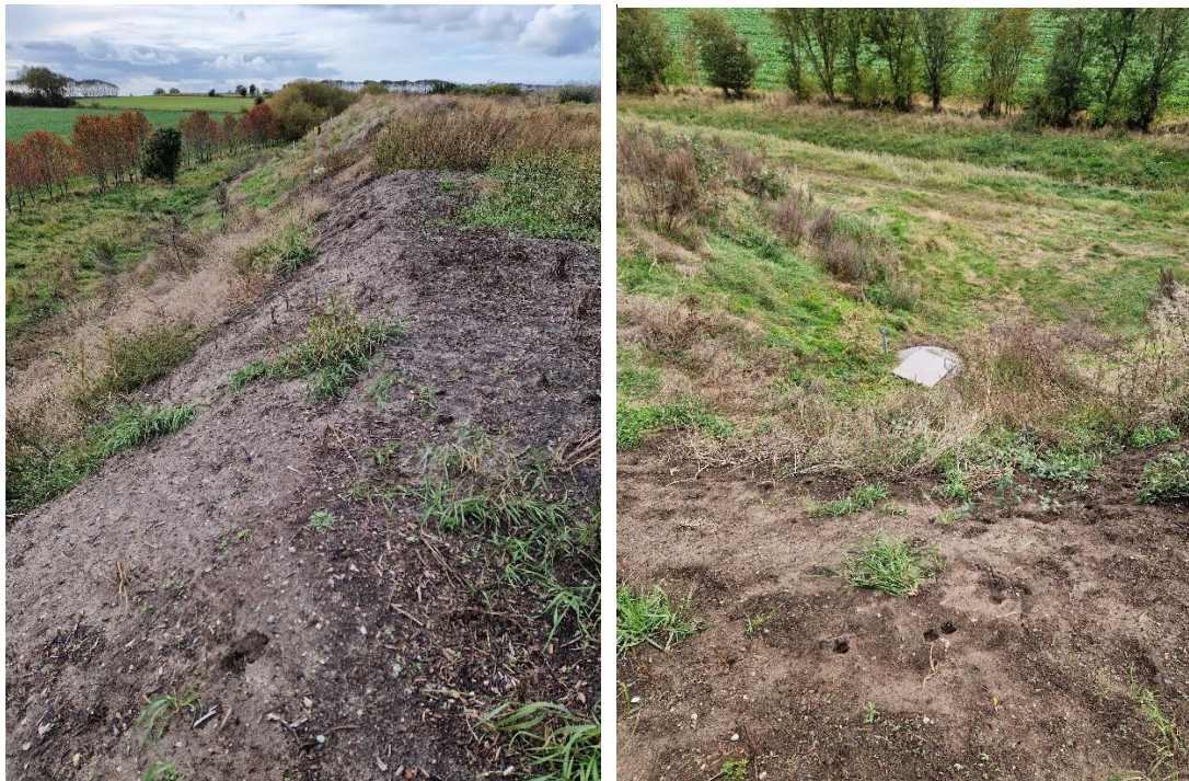
Figur 5. Biocovers etableret på en skråning mod syd.
