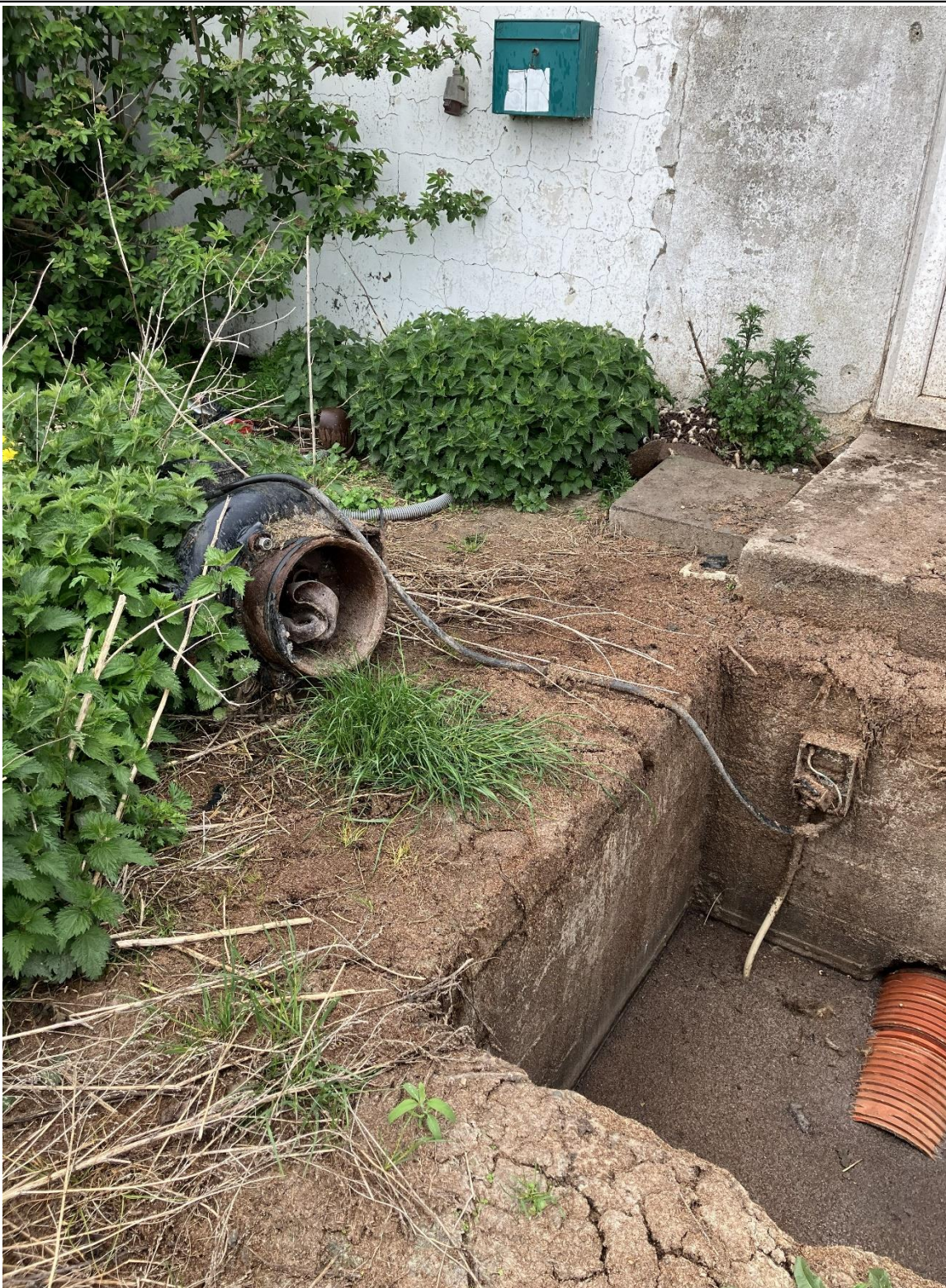
Flue- og skadedyrsbekæmpelse: Tørbrønd
