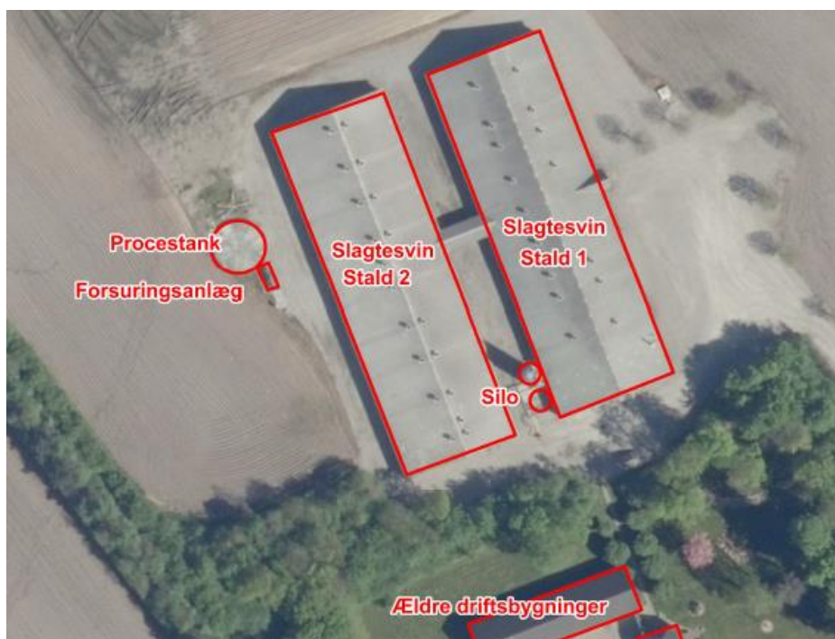
Figur 1. Oversigt over stalde- og foderopbevaringsanlæg og forsuringsanlægget.
