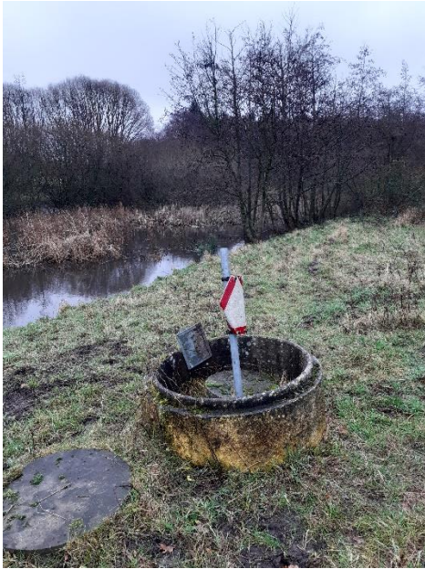
Photo: Stophane ved udløb fra regnvandssystem
