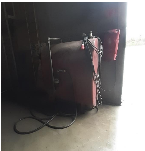
Photo: Dieseltank med pumpe til påfyldning af køretøjer
