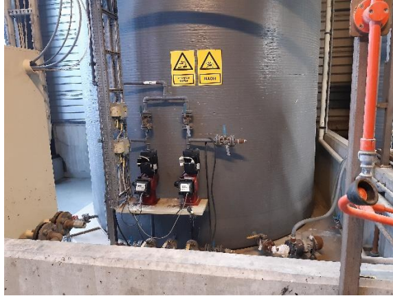
Photo: Tank til NAOH
