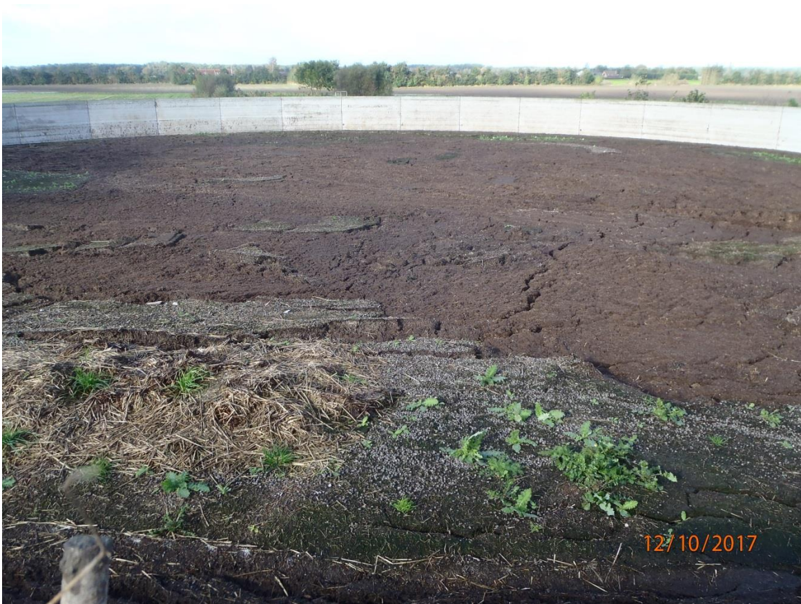
Billederne viser tilstrækkeligt flydelag på beholderen på 2200m 3
