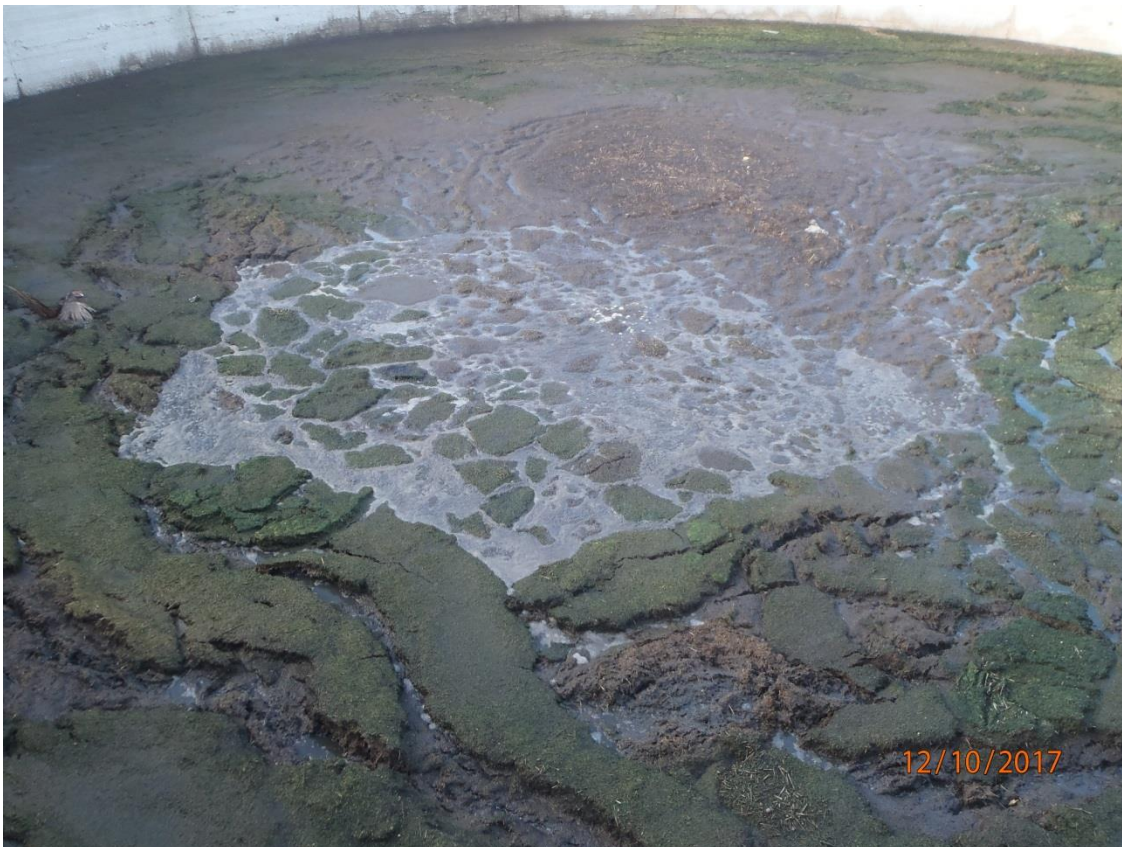
Billederne viser utilstrækkeligt flydelag på beholderen på 750m 3
