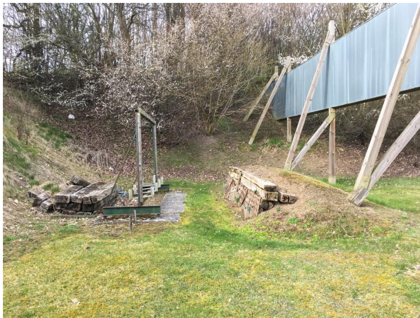
Figur 3 Skivesystem på 25 meter banen. Skiverne anbringes i rammen. Kugler fanges i volden bagved. Øverst til højre ses blænden på 25 meter banen
