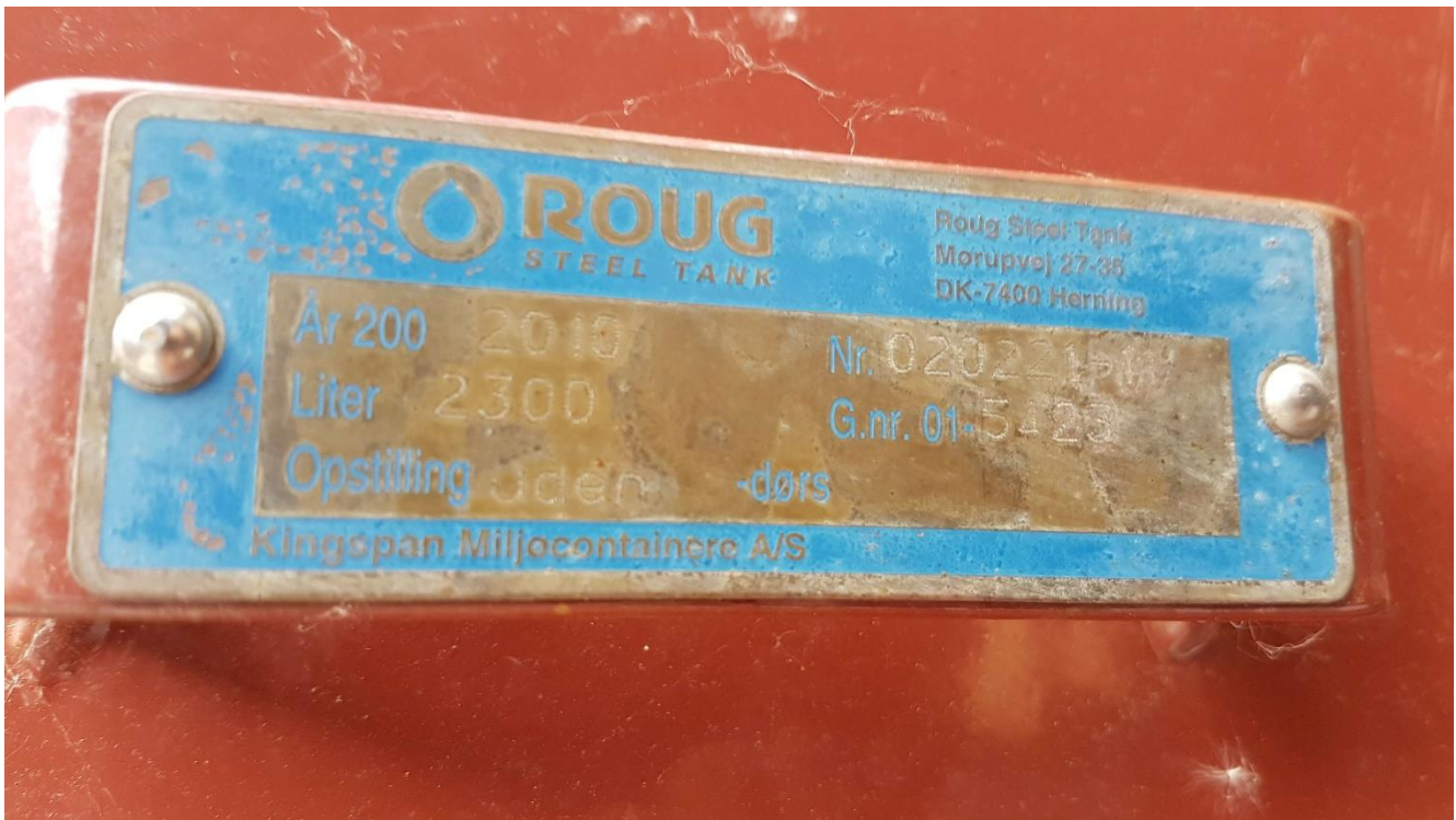
Tankplade på virksomhedens eneste olietank.
