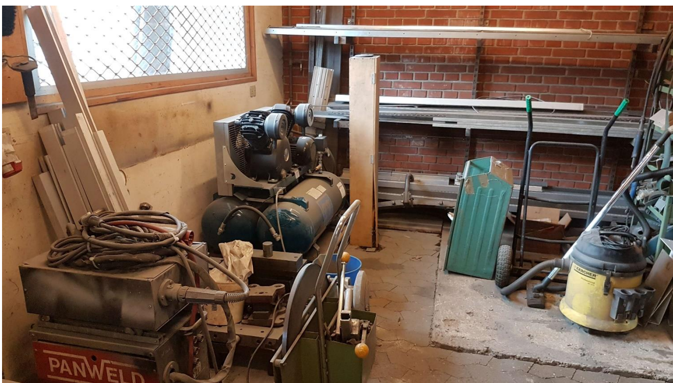
Ny kompressor er opstillet indendørs.
