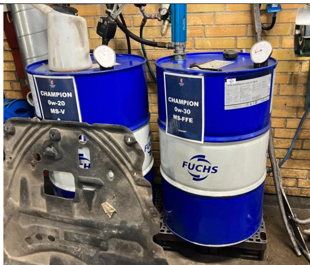
Olie uden opsamling i værksted med afløb
