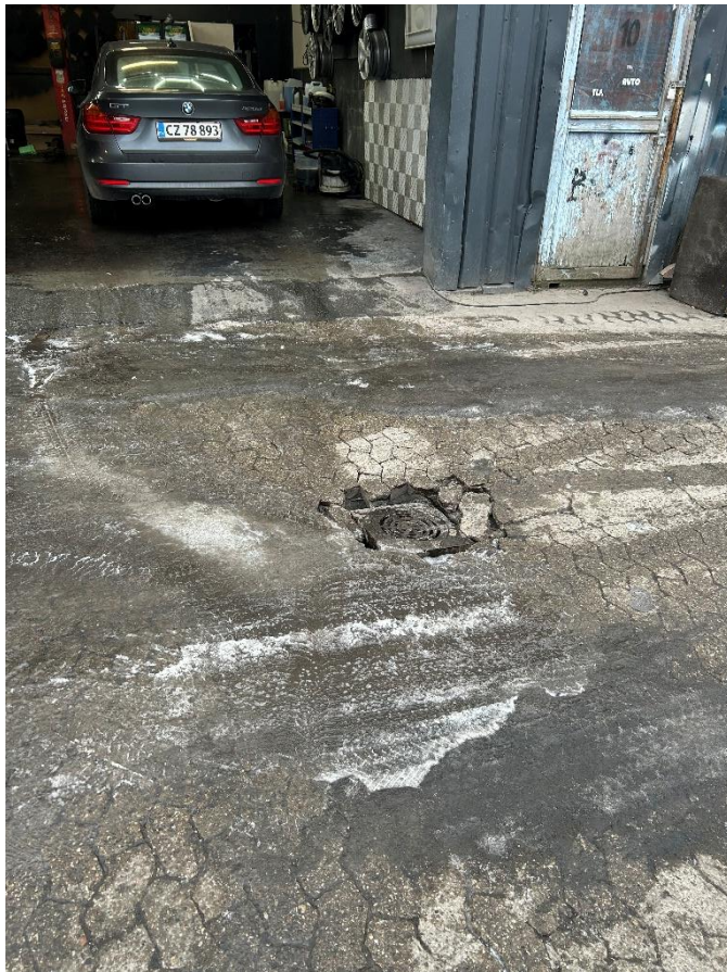
Foto: Afdryp fra undervognsbehandling kan løbe til denne regnvandsbrønd.
