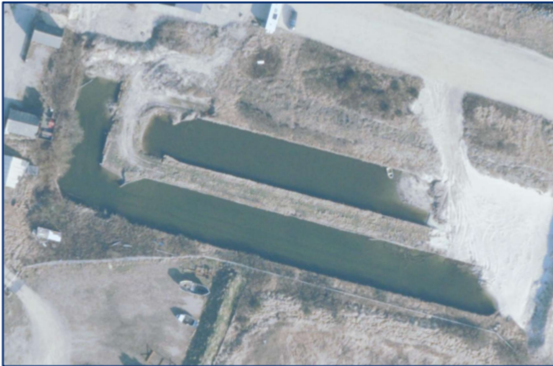
Figur 4: Nyttiggørelsesområdet, hvor de tidligere bassinafgrænsninger tydeligt ses. Det er muligt at skabe adgang til området fra flere sider. © GeoDanmark, © KDS.
