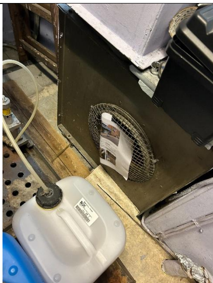
Figur 6: Virksomhedens ventilations sugsevne bliver testet ved hjælp af et A4-papir.
