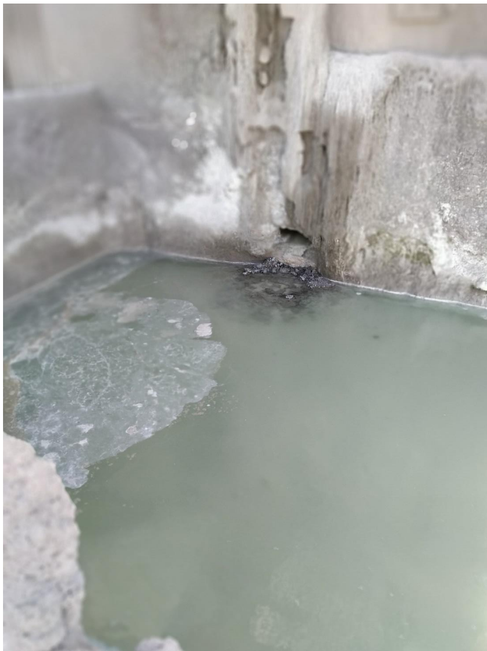
Figur 33. Vand tilledes slambassinet via hul i mur ind til støbehal 6.
