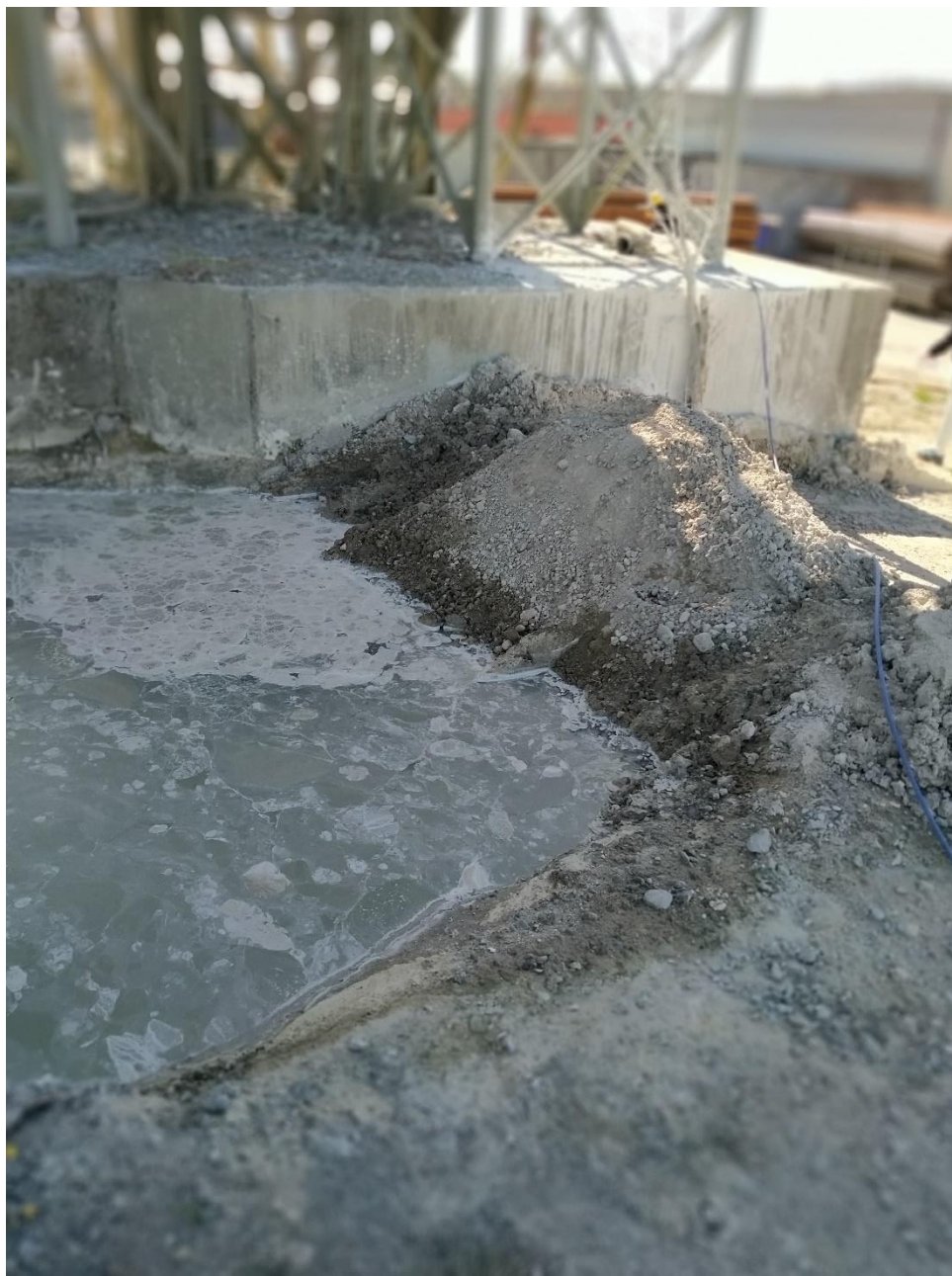
Figur 34. Grusbunke der tilbageholder vand fra slambassin D.
