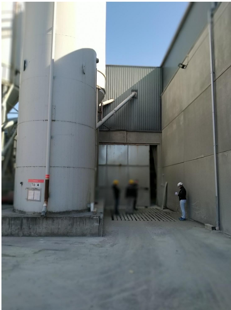
Figur 30. Slambassin J er beliggende ved blandemaskiner ved støbehal 10.
