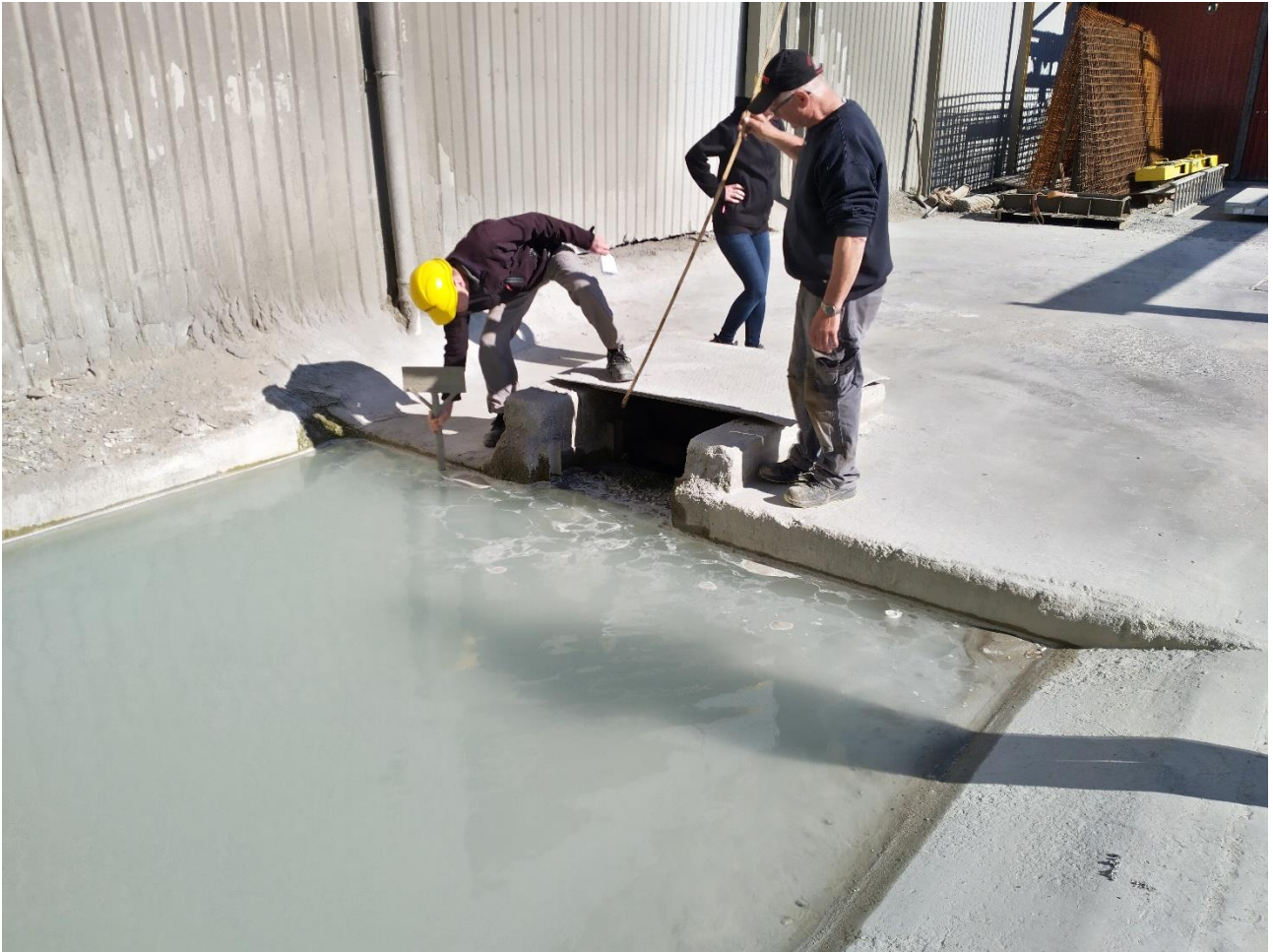
Figur 9. Stenfilter (granitskærver) hvor vaskevand via overløb ledes til bundfældningstank.
