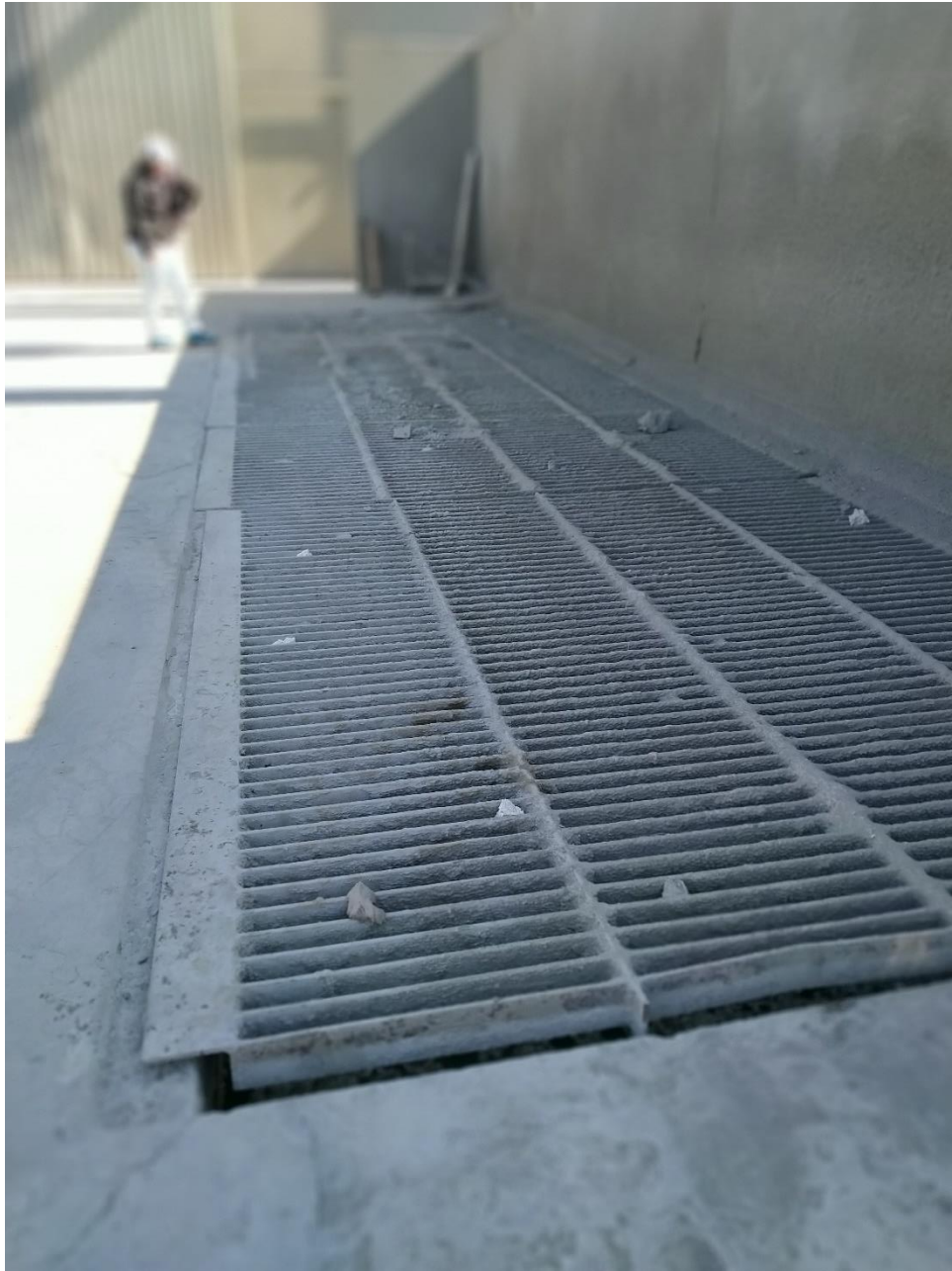
Figur 23. Slambassin K, hvor der vaskes facadeelementer ovenpå ristene.
