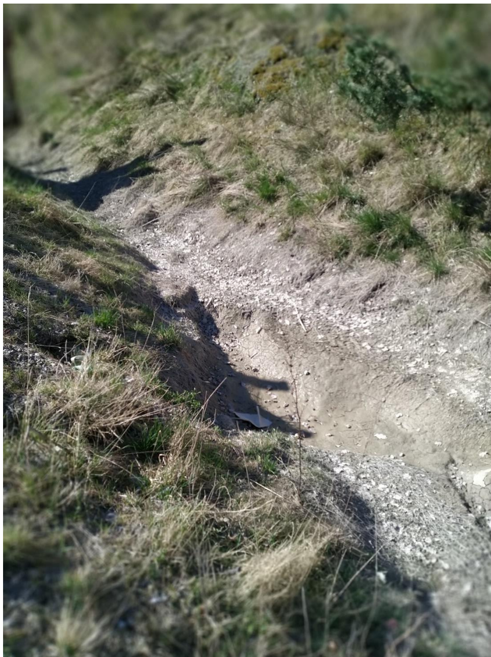
Figur 21. Nedsivningsgrøft med tydelig aflejring af betonslam
