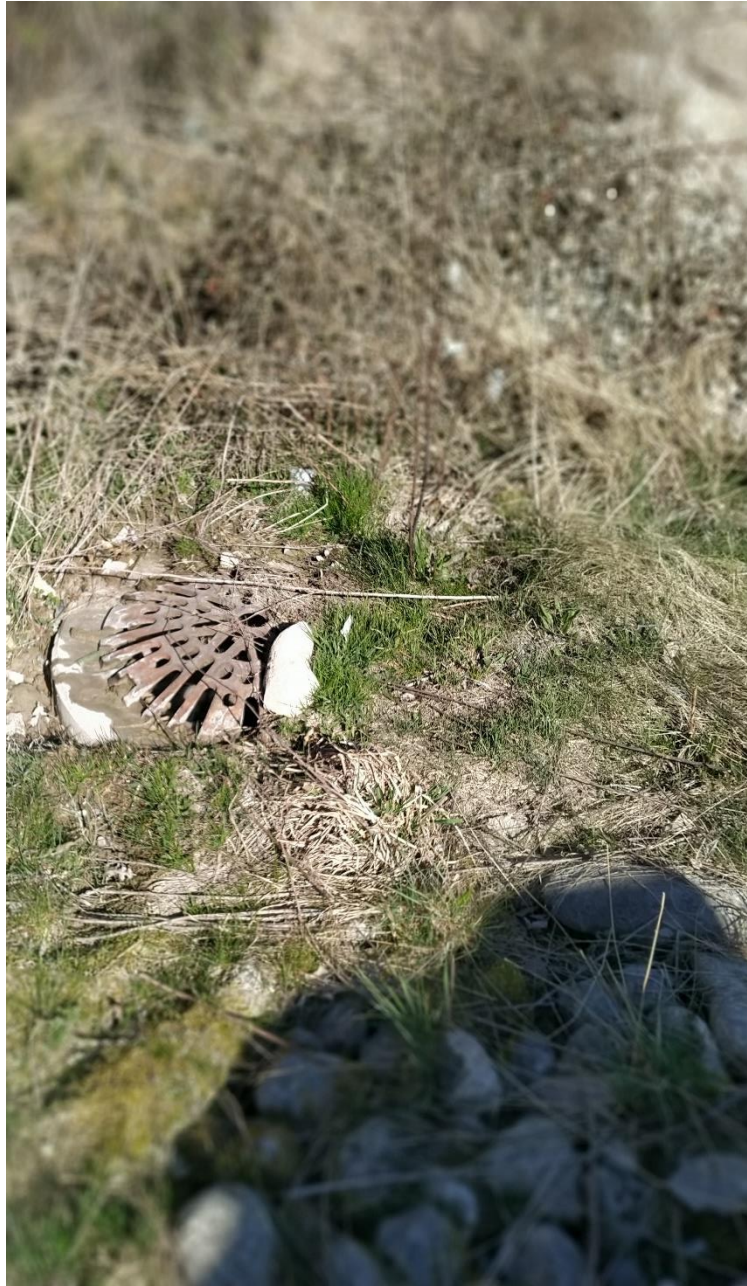
Figur 22. Samlebrønd placeret i nordligste ende af nedsivningsgrøft.
