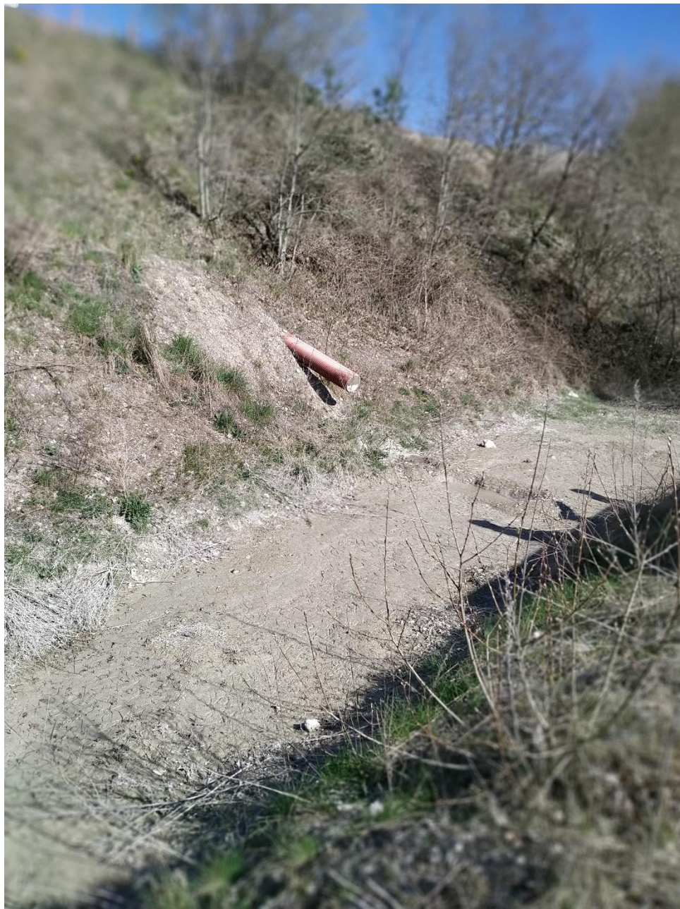
Figur 20. Afledning af overfladevand fra oplagsplads af færdigelementer. Her ses det nordligste af de 2 rør, som leder fra oplagspladsen til nedslivningsgrøften.
