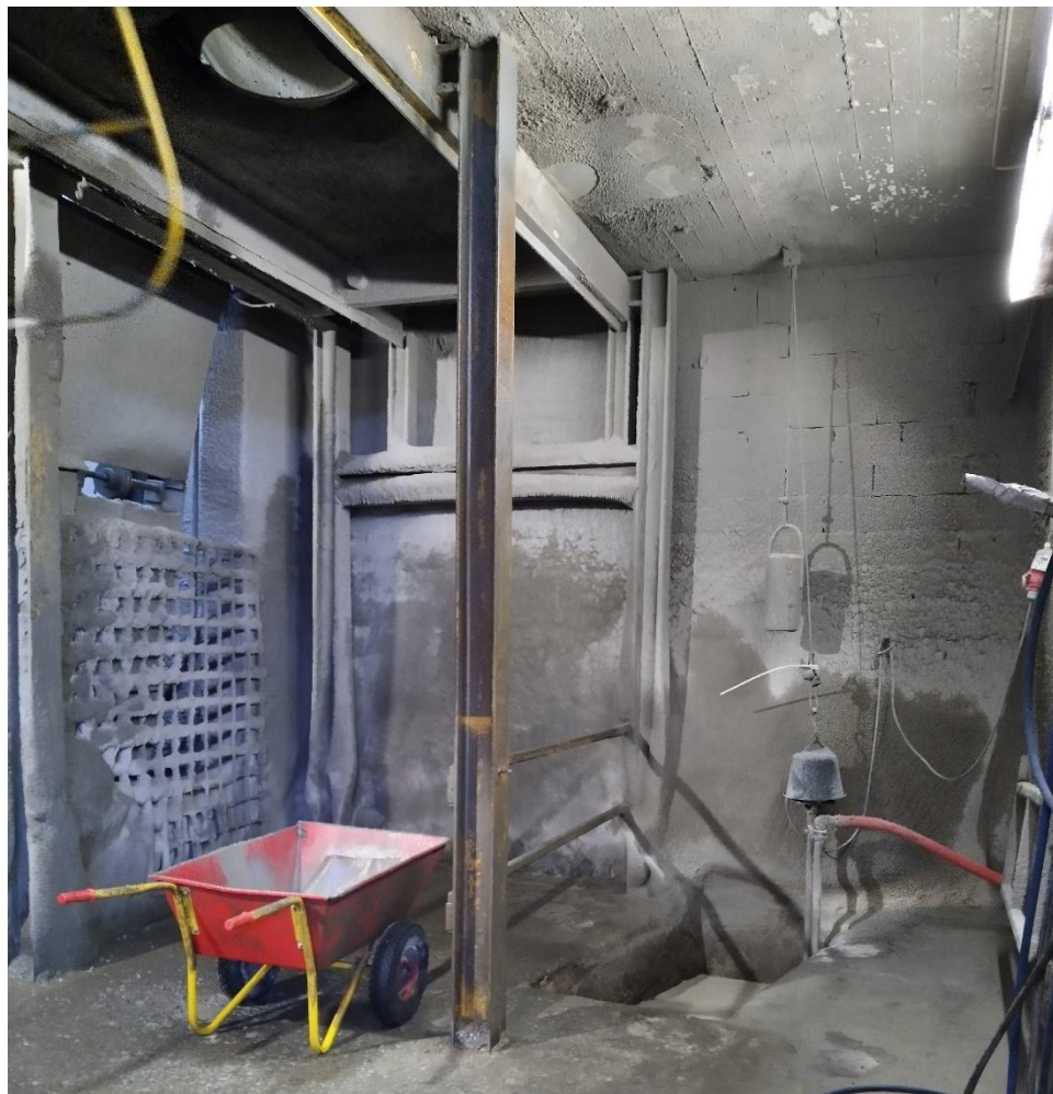
Figur 1. Vaskevand fra conveyer, der pumpes via rødt plastrør til slambassin A.
