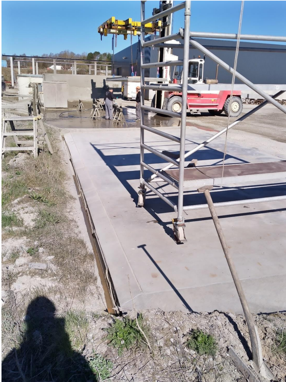
Figur 14. Vaskeplads H i forgrunden.
