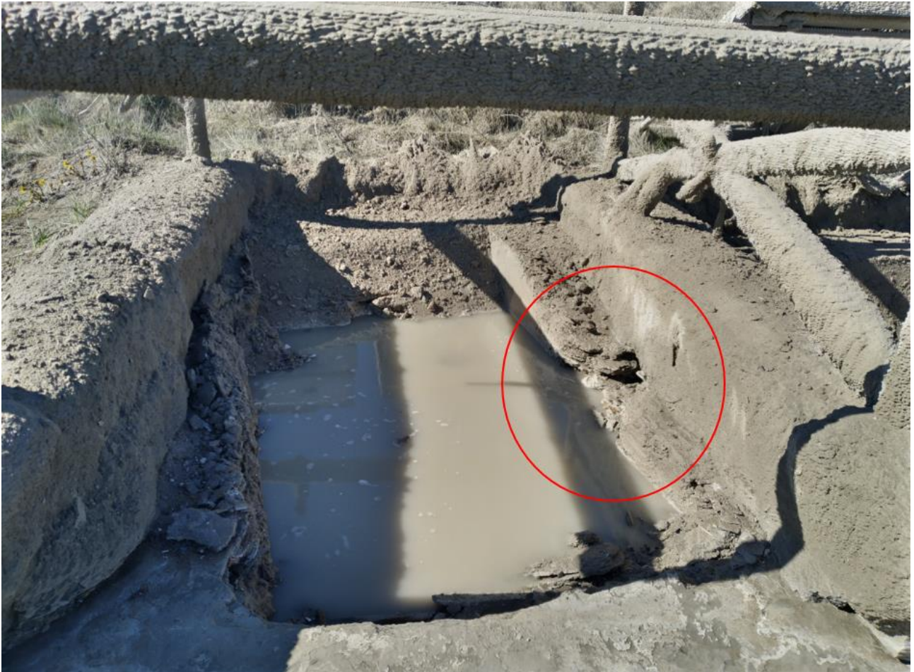
Figur 17. "Kar" på vaskepladsen. Den røde ring markerer, hvor der er overløb til næste kar.
