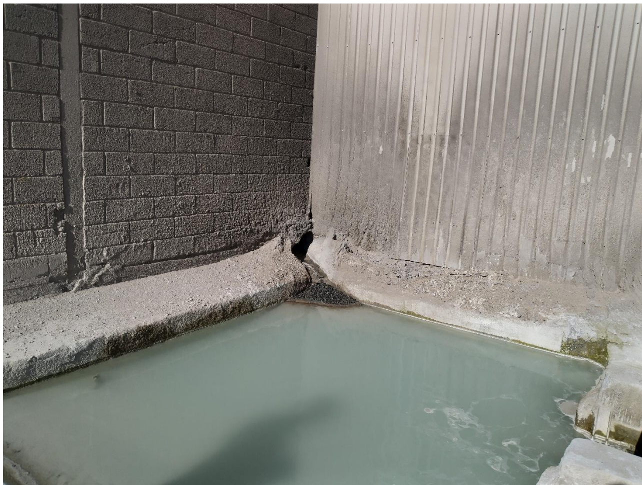
Figur 8. Hul/rende hvor vaskevand ledes til slambassin C.
