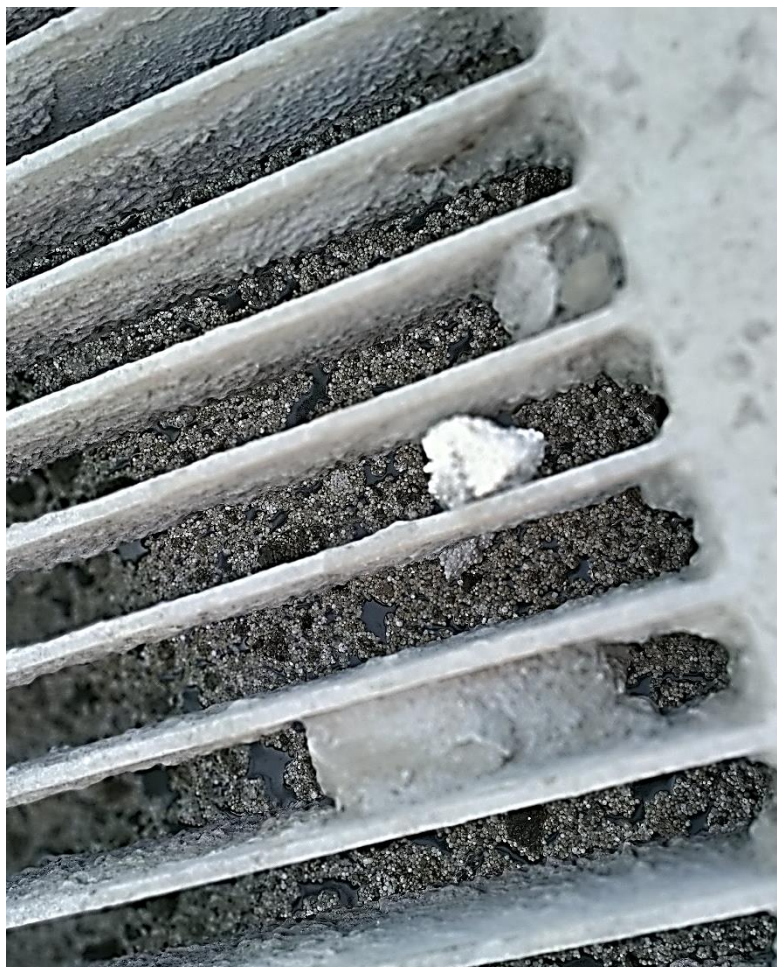
Figur 24. Flydelag af flamingo i varierende størrelse i slambassin K.
