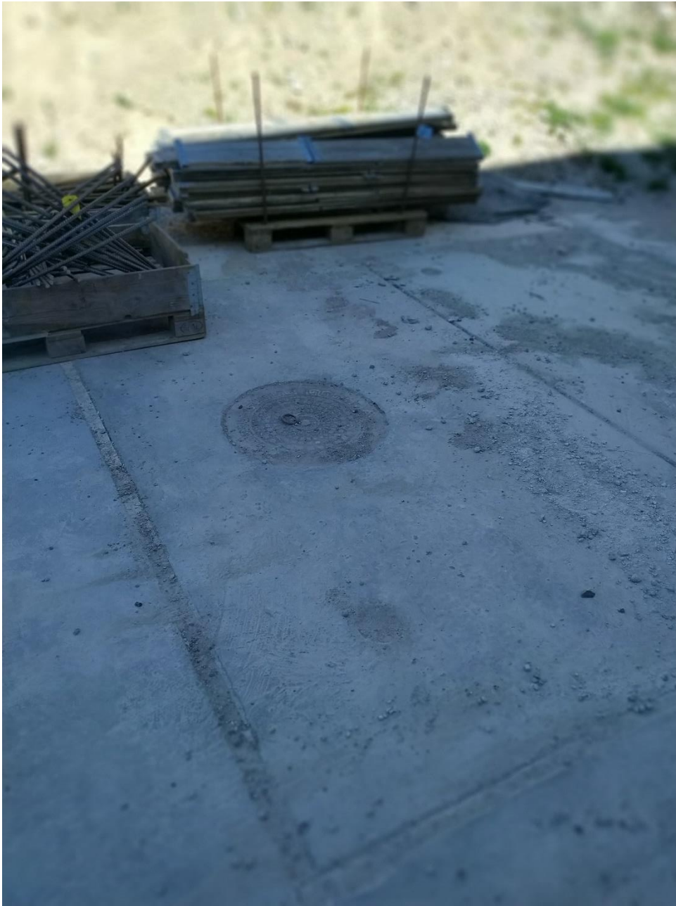
Figur 31. Bundfældningstank tilkoblet slambassin J. Bundfældningstanken er placeret ved silo-batteri ved hal 10.
