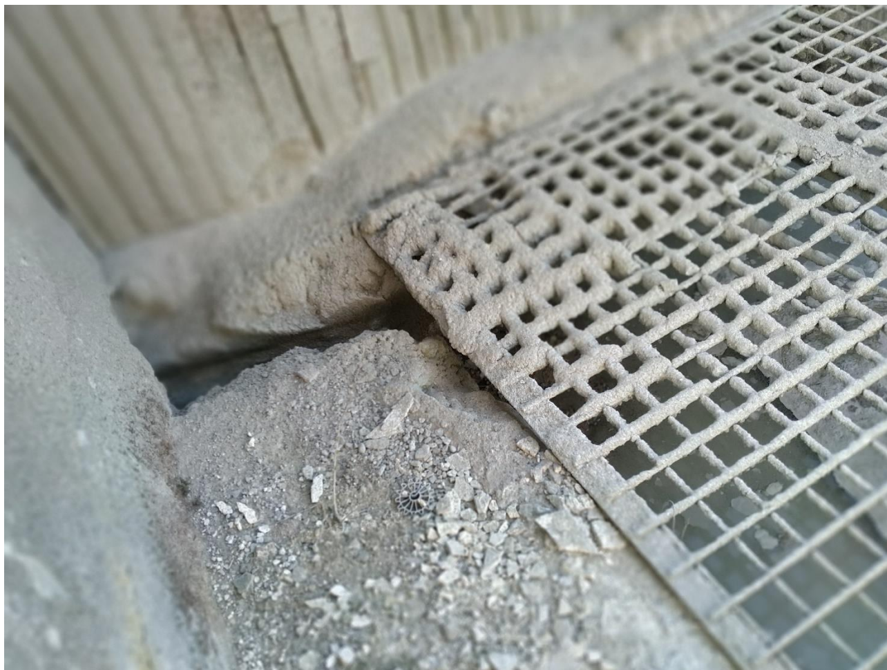
Figur 37. Tilledning af vand til slambassin E via hul i væggen ind til støbehal 6.
