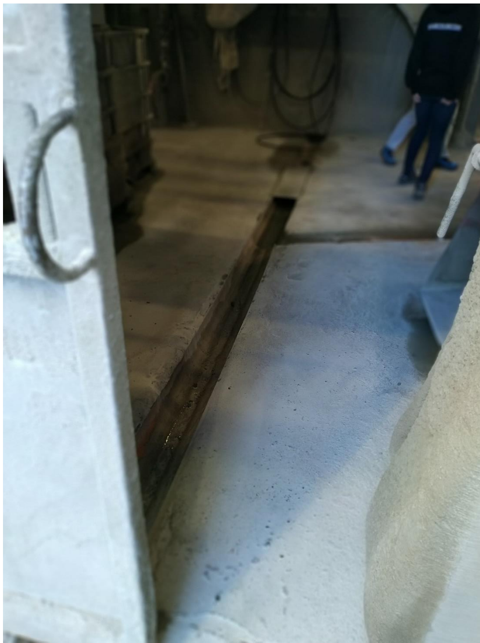
Figur 28. Vaskevand ledes via rende i gulvet til slambassin J.
