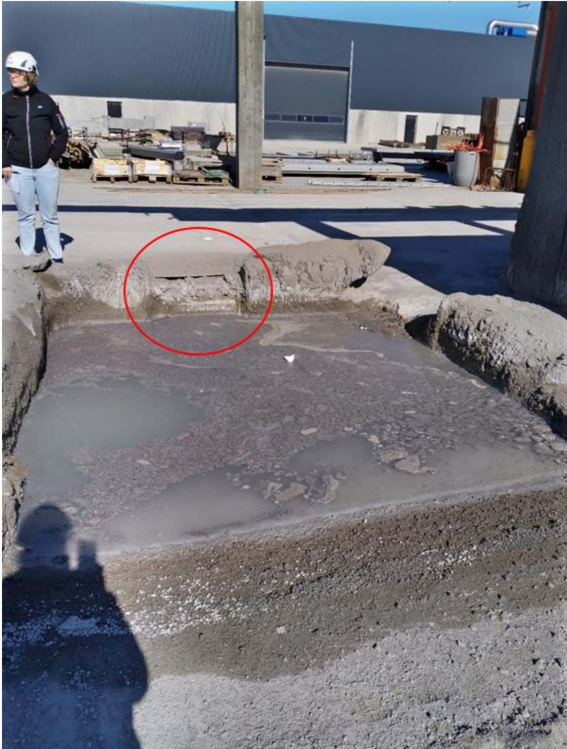
Figur 12. I slamlaget på bassinet bestod bl.a. af Leca. Den røde cirkel markerer risten – her ledes vaskevandet videre til bundfældningsbassin og derefter nedslivningsgrøft.
